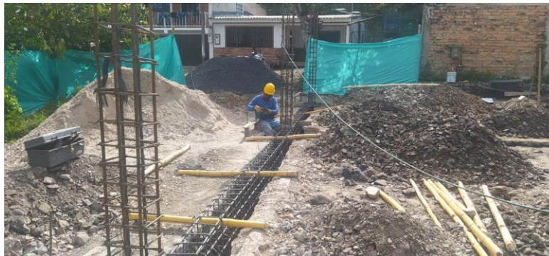
Figura 2 Evidencia fotográfica avance de obra segunda visita de campo.
