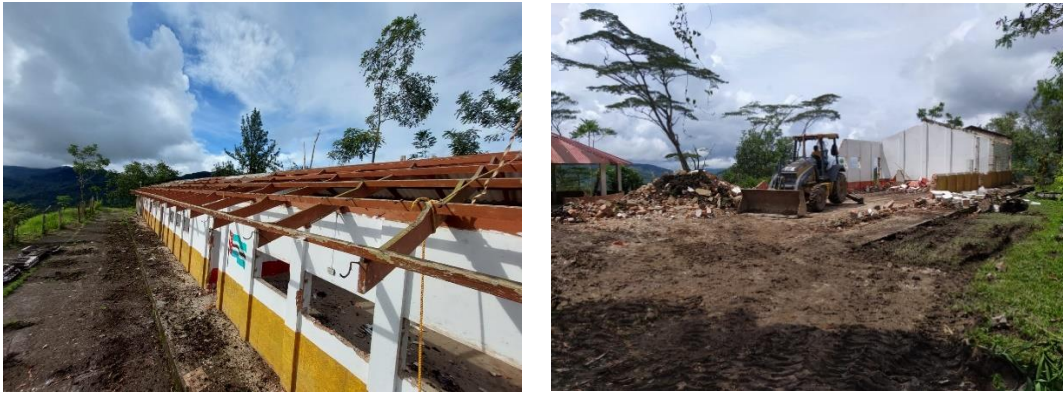
Figura 1 Evidencia fotográfica avance de obra primera visita de campo.
