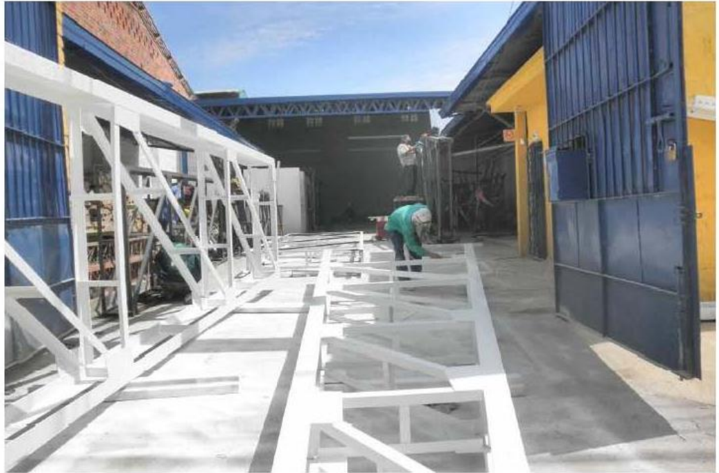
CERCHAS EN FABRICACIÓN (BODEGA GAITÁN)
