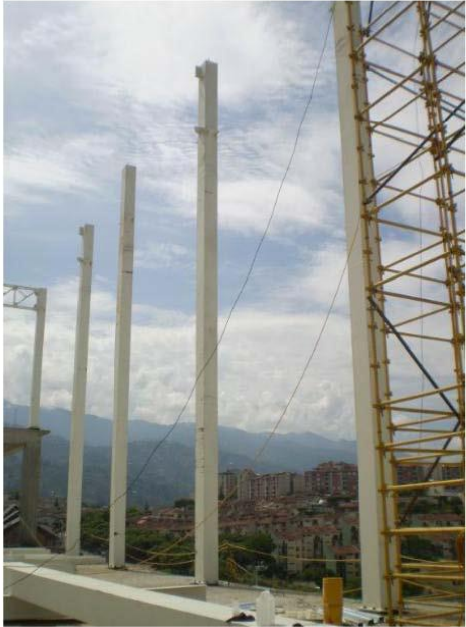
MONTAJE E INSTALACIÓN (Columnas borde de Placa)
