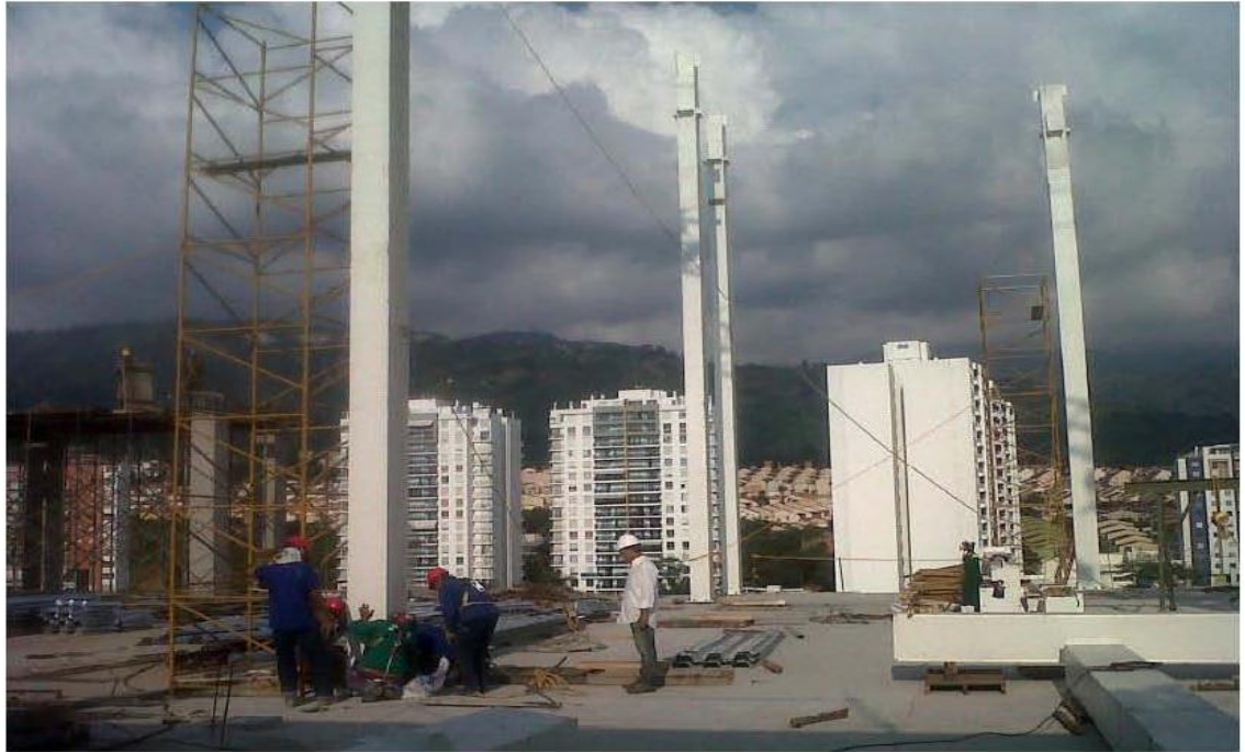
MONTAJE E INSTALACIÓN (Columnas Izadas)
