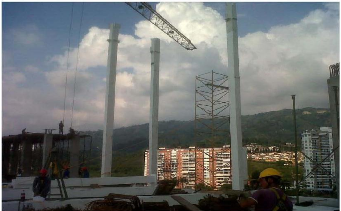
MONTAJE E INSTALACIÓN (Columnas Izadas)
