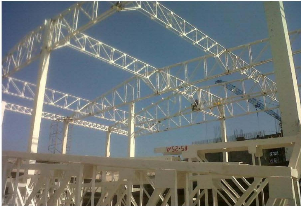
MONTAJE E INSTALACIÓN (Cerchas y Pórticos)
