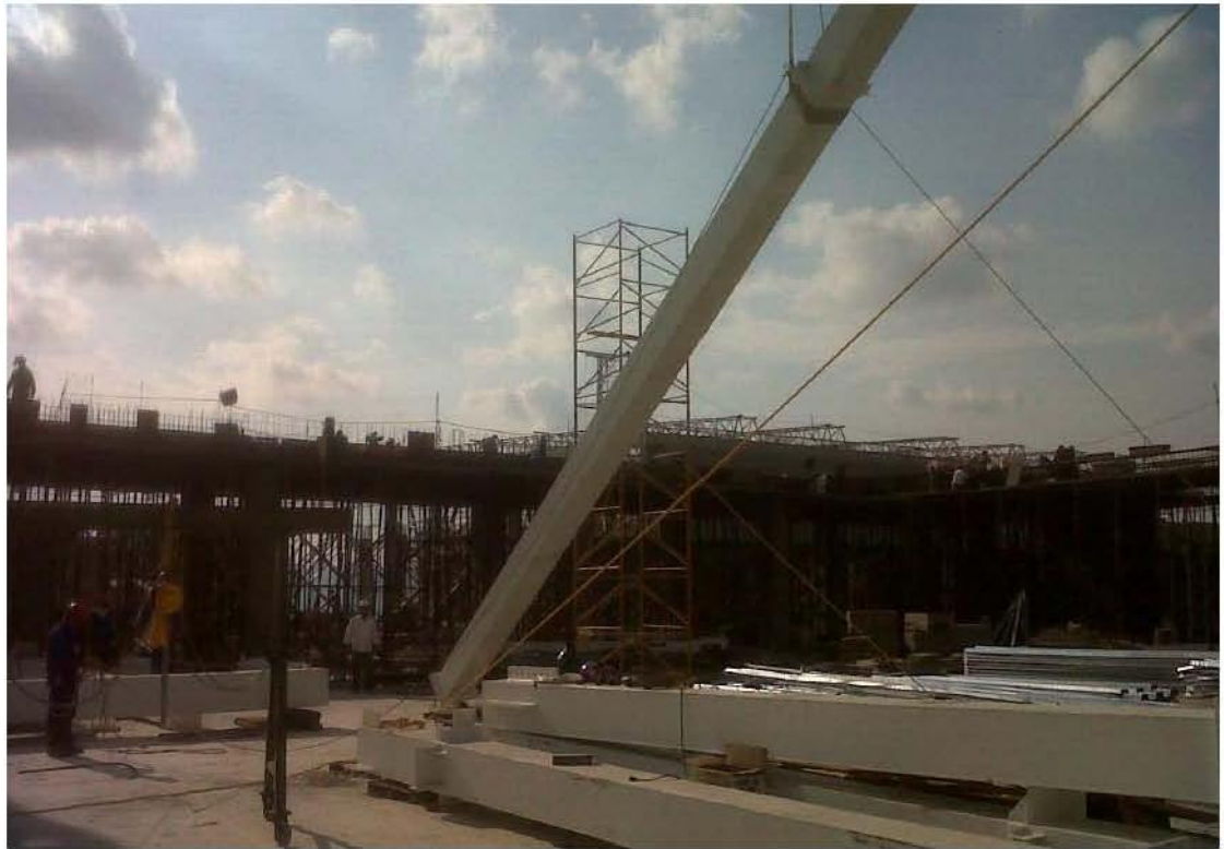
MONTAJE E INSTALACIÓN (Columnas Izadas)
