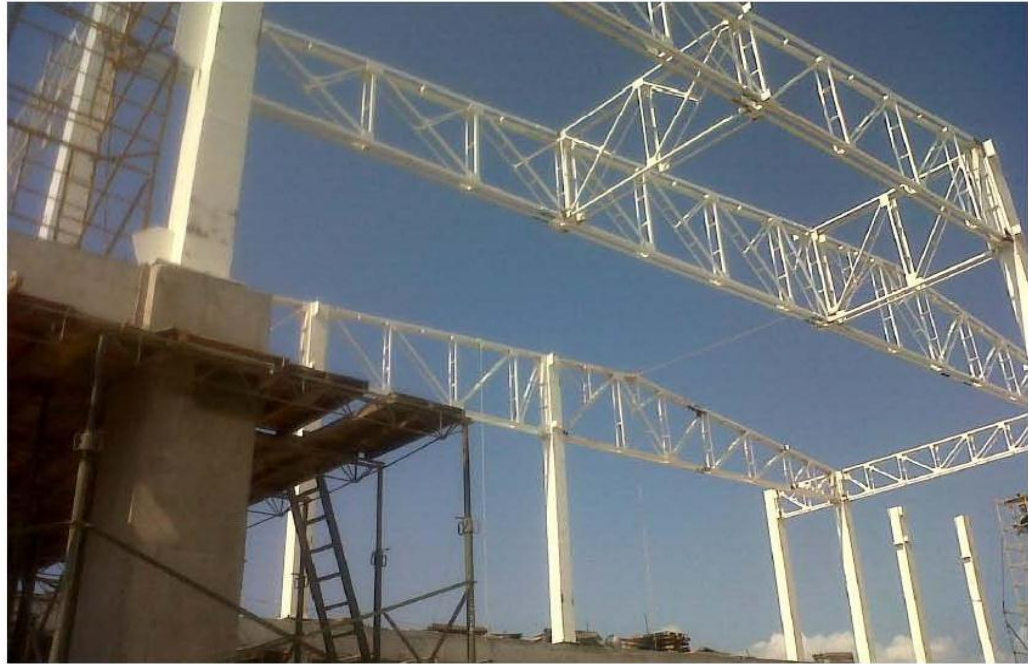
MONTAJE E INSTALACIÓN (Cerchas y Pórticos)
