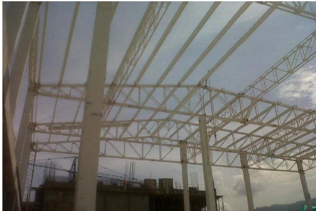
MONTAJE E INSTALACIÓN (Correas)
