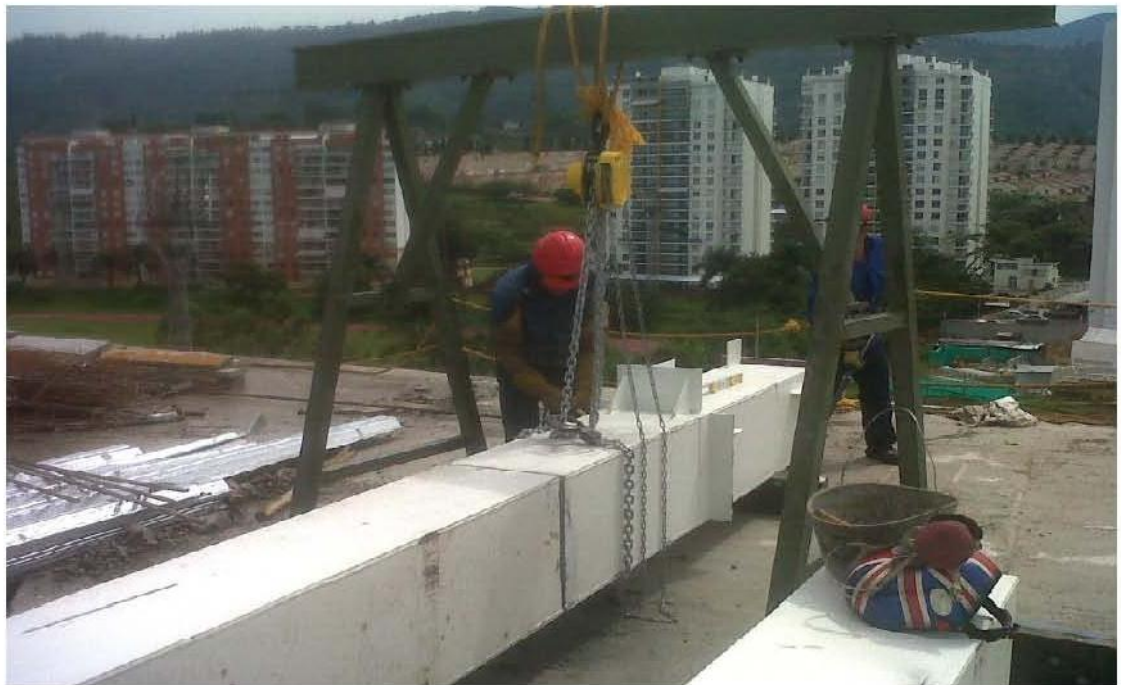
MONTAJE E INSTALACIÓN (Columnas Izadas)
