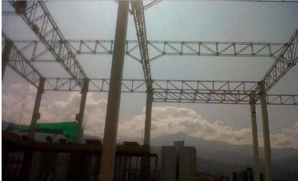
MONTAJE E INSTALACIÓN (Cerchas y Pórticos)
