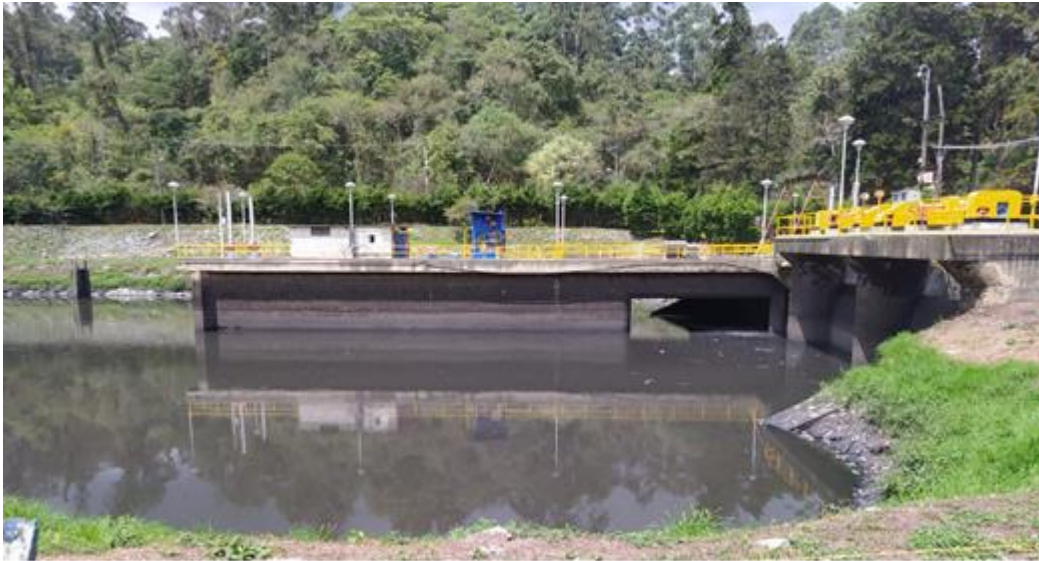
Imagen 4: Bocatoma Darío Valencia Samper
