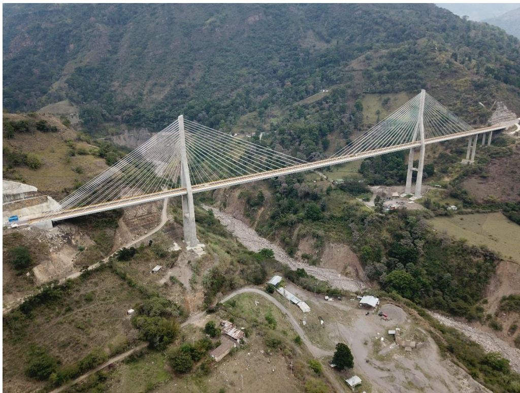
Fotografía 2. Puente Hisgaura, vista costado occidental, sentido norte a sur ((izquierda-derecha). Febrero de 2019.
