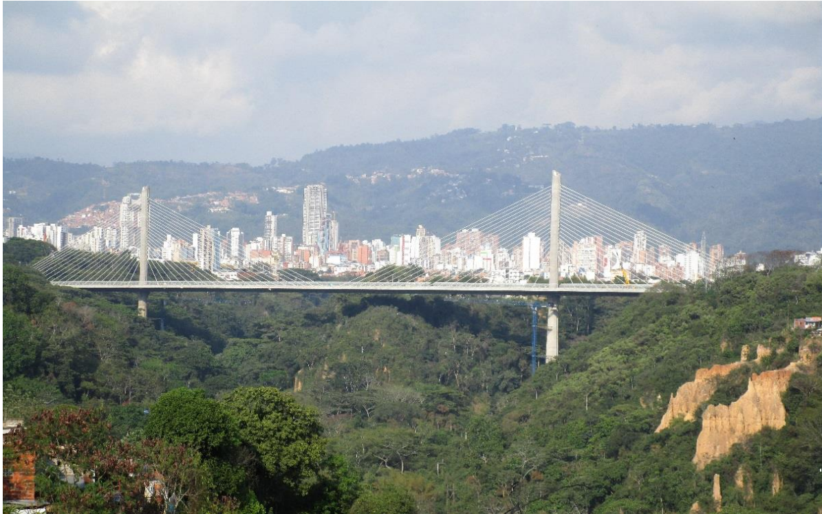
Fotografía 1. Viaducto Provincial (La Novena) en Bucaramanga, Santander, Colombia. 2015.
