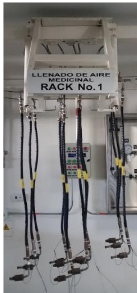
Figura 7. Rack de llenado aire sintético
