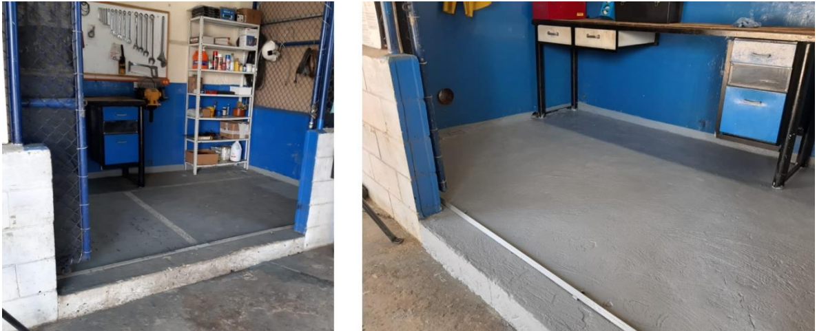
Figura 27. Taller mantenimiento, después de 5´s.
