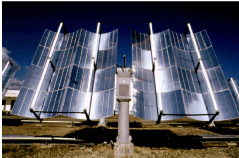
Figura 2.9. Colector cilindro-parabólico con seguimiento en dos ejes instalado en la PSA [10].
