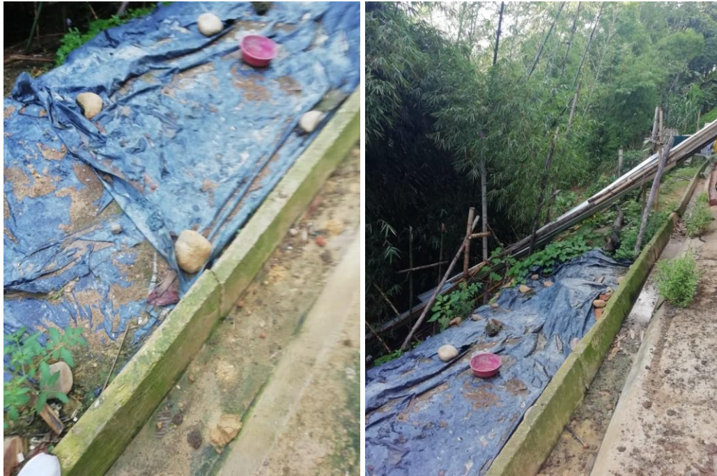
Ilustración 5: Canaleta para la conducción del flujo de escorrentía
