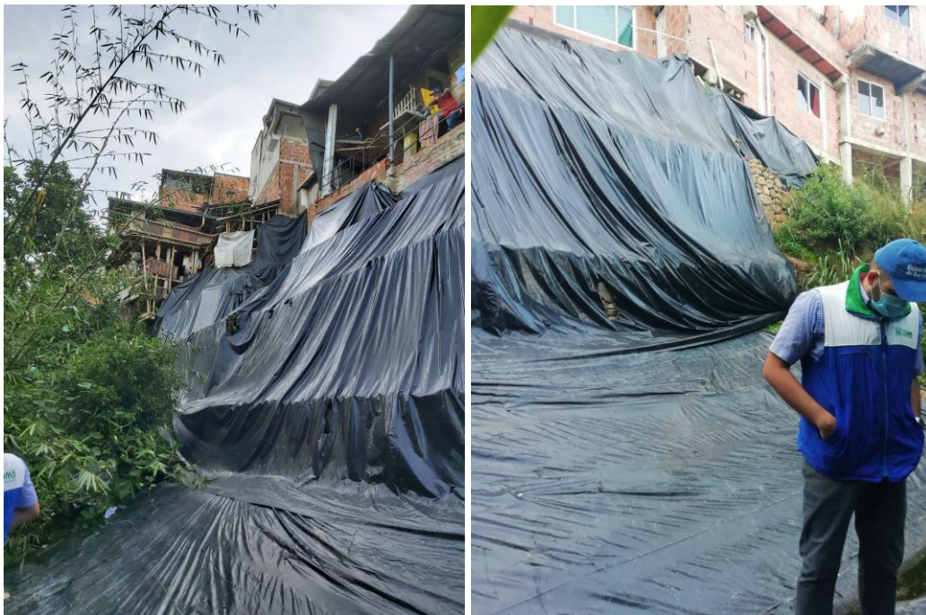
Ilustración 4: Impermeabilización con plástico de polipropileno color negro
