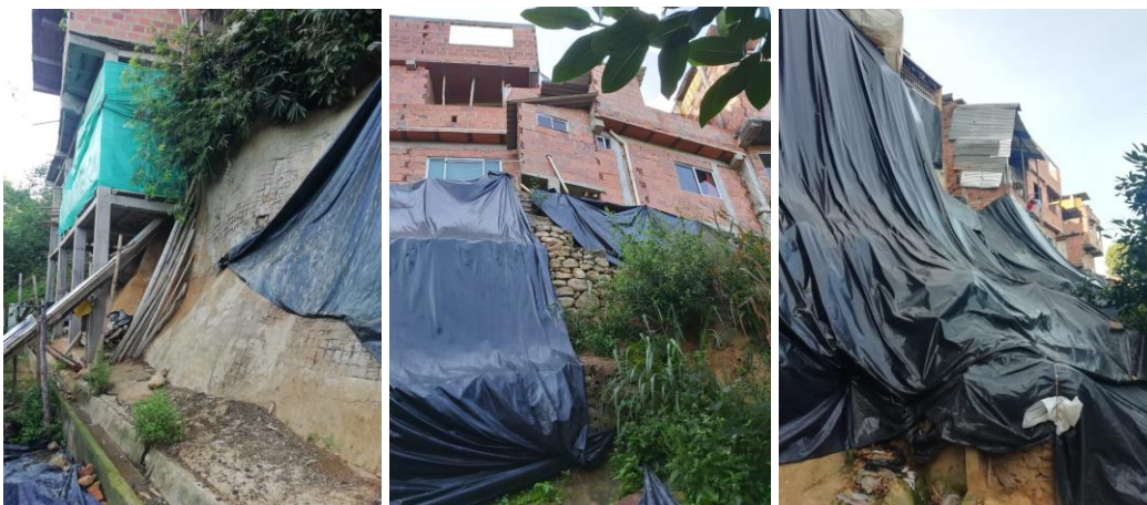
Ilustración 2: Obras de mitigación presentes en el sector objeto de visita
