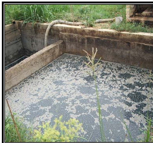
Foto 4. Tanque de Lixiviados
