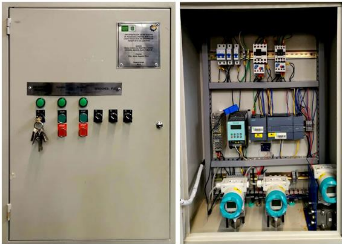
Figura 13 Subsistema eléctrico, electrónico y de control
