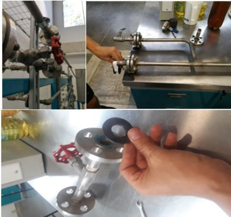
Figura 18 Corrección de las fugas
