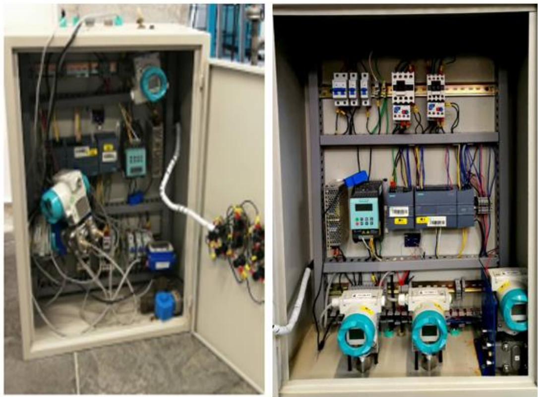
Figura 20 Tablero de control antes y después
