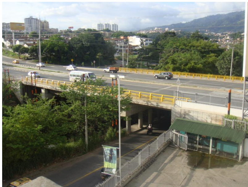
Figura 2. Puente Cañaverál, Autopista Bucaramanga - Floridablanca
