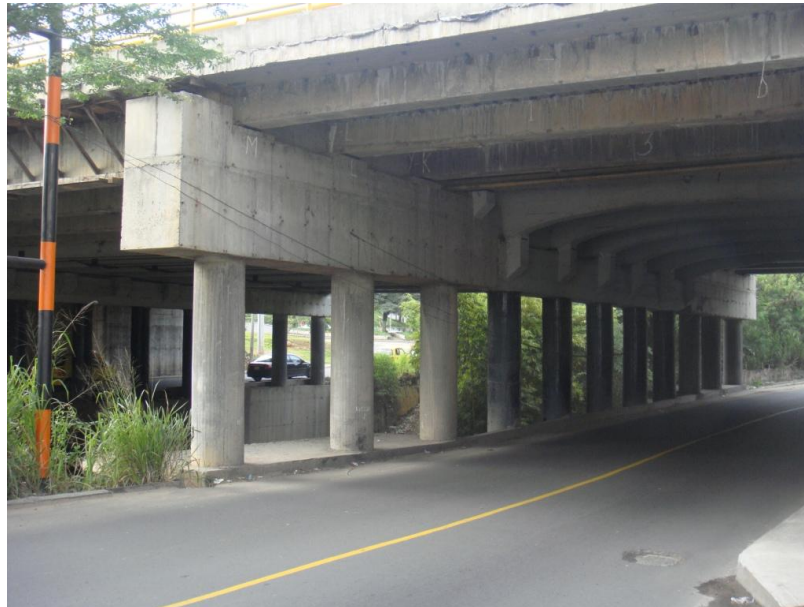
Figura 4. Infraestructura del puente Cañaveral
