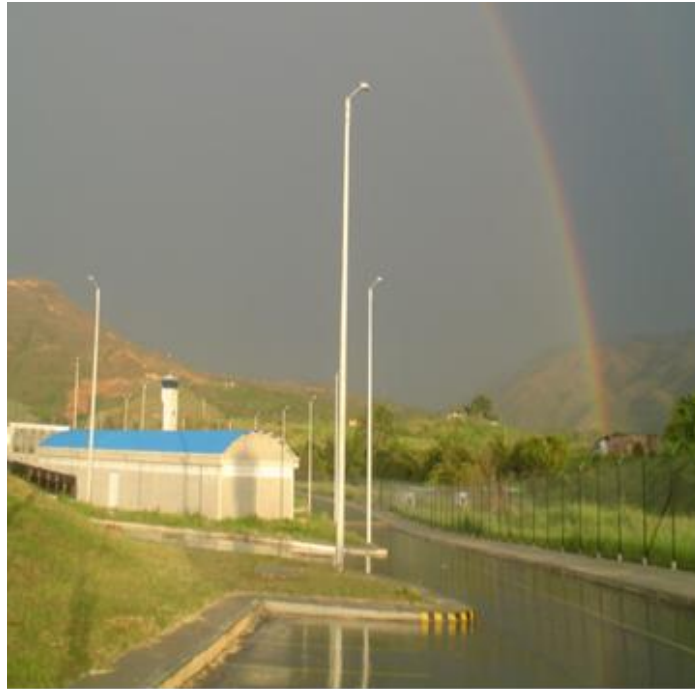
Figura 87. Vista del Almacén General.
