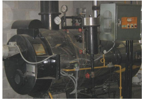
Figura 25. Caldera Alternativa de 20 BHP.
