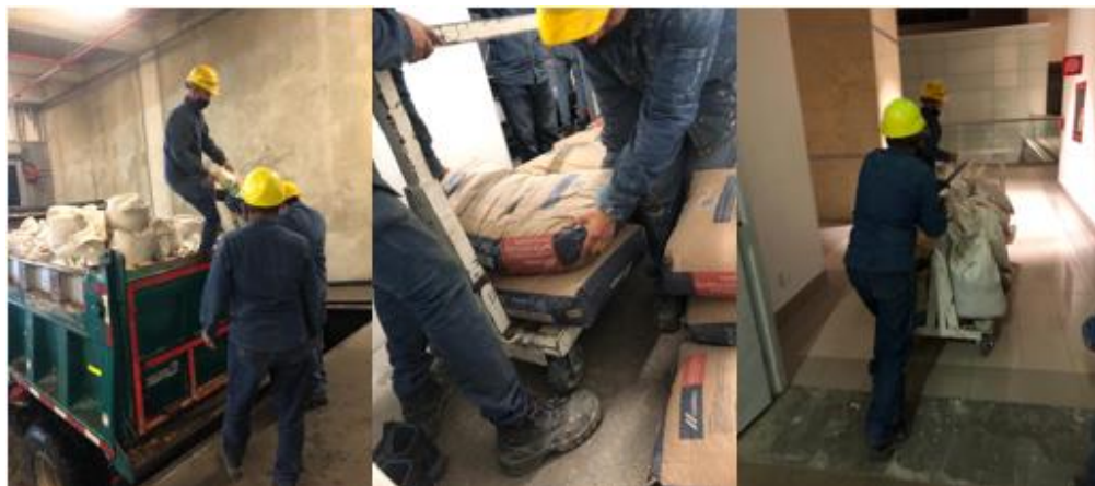
Figura 11. Ingreso del material a la obra
