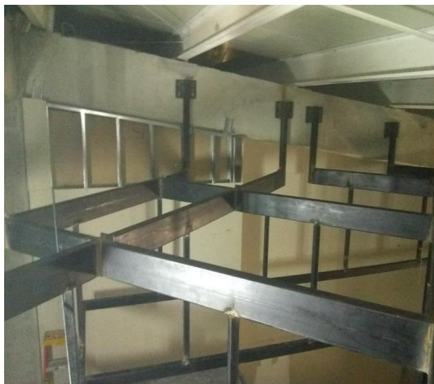
Figura 8. Estructura metálica de techo finalizada
