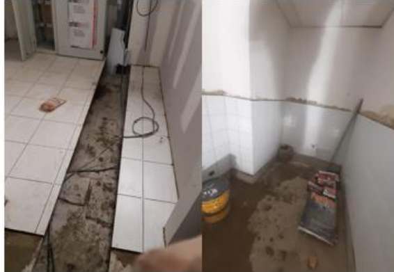
Figura 18. Enchape cuarto técnico y baño
