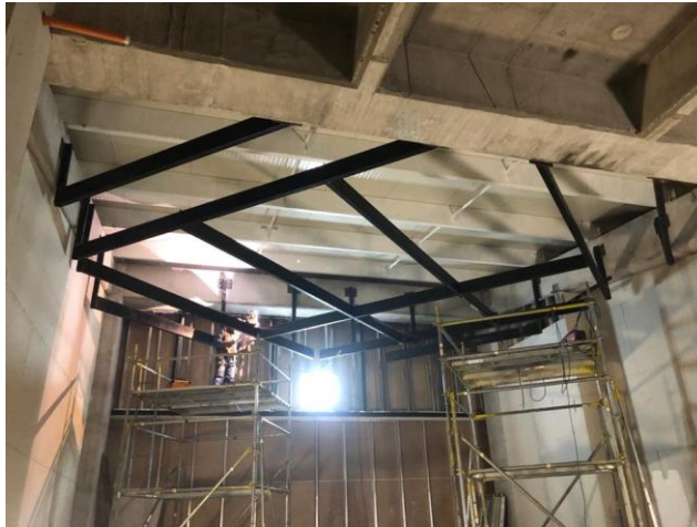
Figura 7. Montaje estructura metálica de techo
