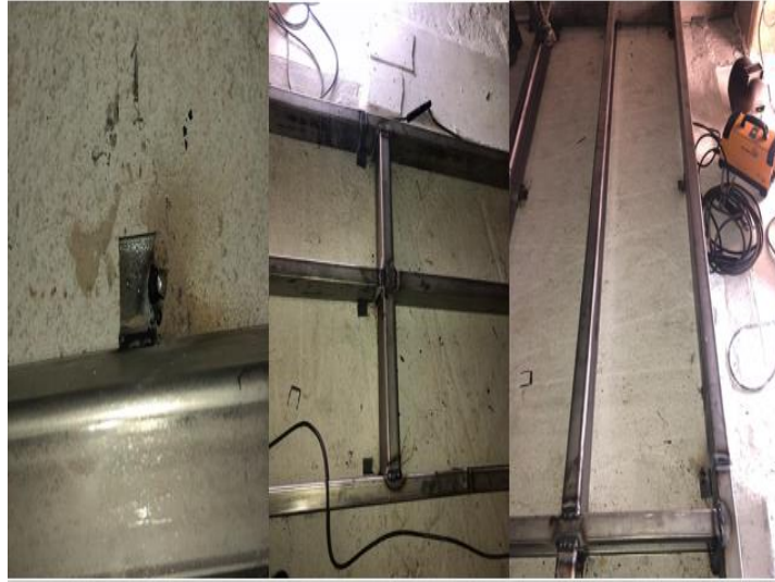
Figura 3. Anclaje de plataforma metálica a placa de entpiso del local
