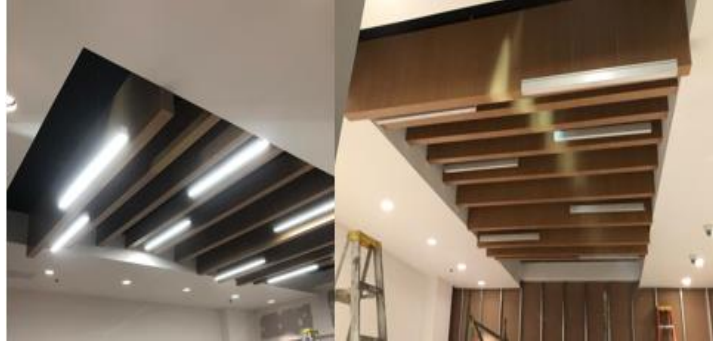
Figura 23. Perfiles de madera y luminarias
