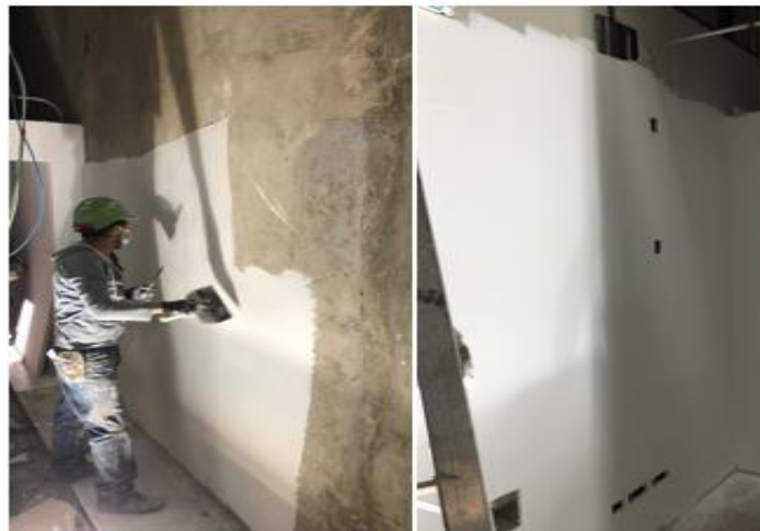
Figura 24. Pintada de muros
