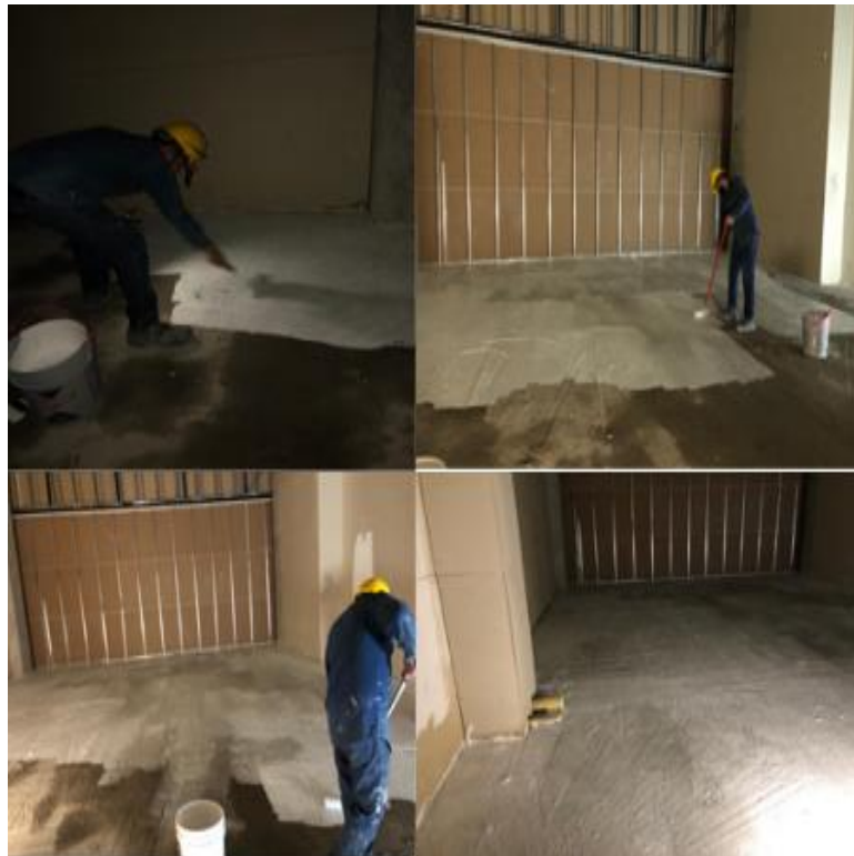
Figura 1. Impermeabilización de placa
