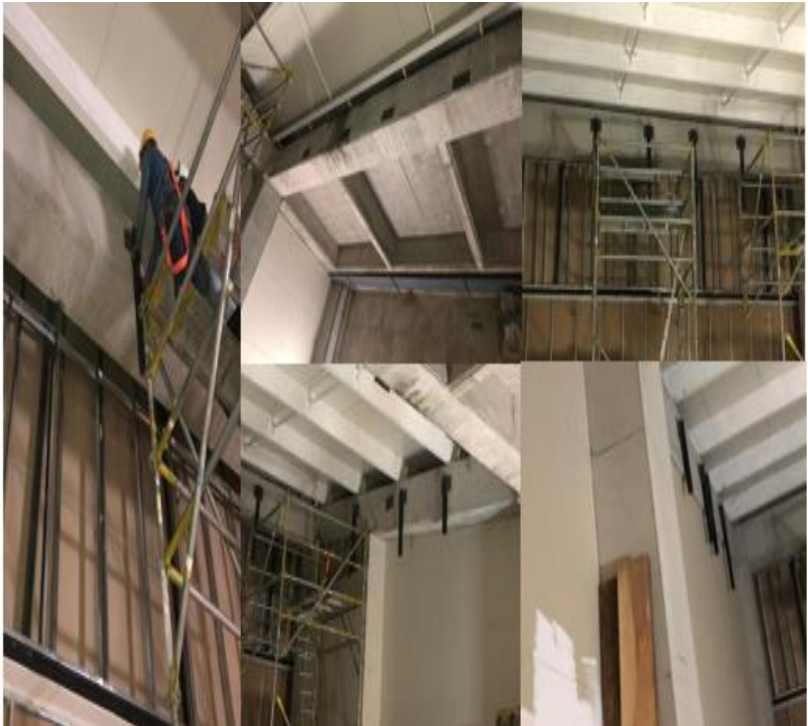
Figura 6. Anclaje de platinas
