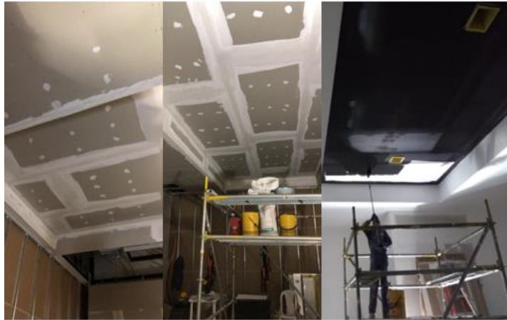
Figura 16. Instalación y pintura de cielos rasos
