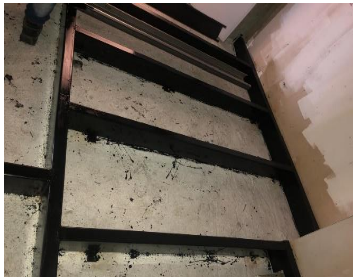
Figura 4. Aplicación de pintura anticorrosiva
