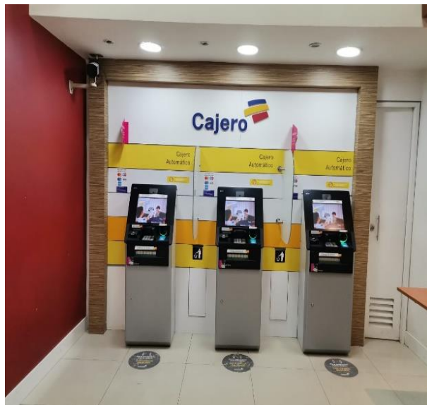
Figura 28. Cajeros nuevos instalados
