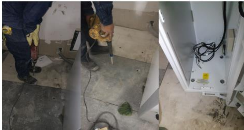
Figura 20. Anclaje de cajeros
