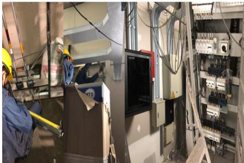
Figura 15. Instalación parte eléctrica y electrónica
