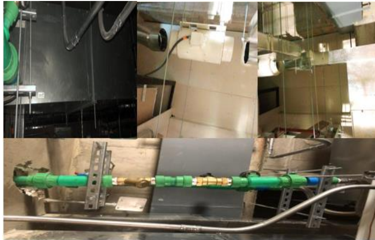
Figura 25. Instalación aire acondicionado con su respectiva tubería
