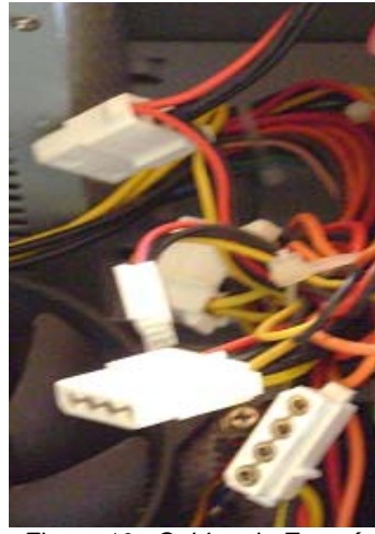
Figura 10. Cables de Energía Fuente: Autor.
