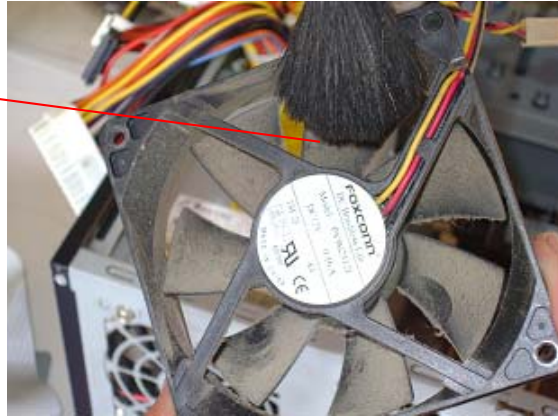
Limpieza de los ventiladores.
