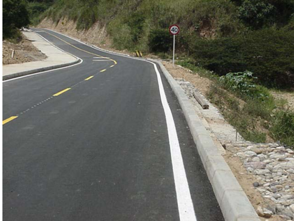
IMAGEN 12. Estado final de la Transversal del Porvenir
