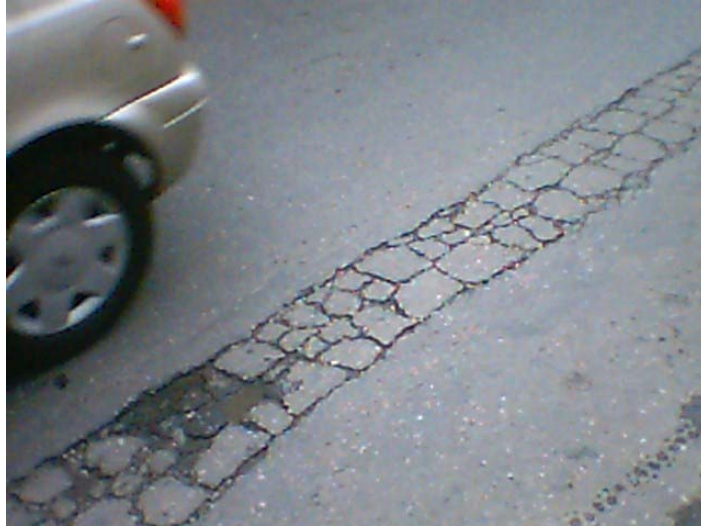
IMAGEN 2: Estado original de las vías No. 2
