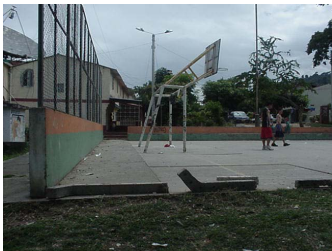
IMAGEN 14. Estado original del polideportivo No. 2
