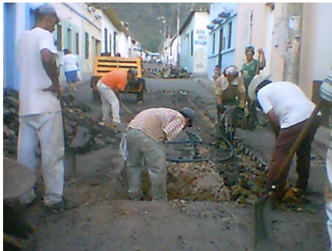
IMAGEN 3: Ejecución de las obras No. 1
