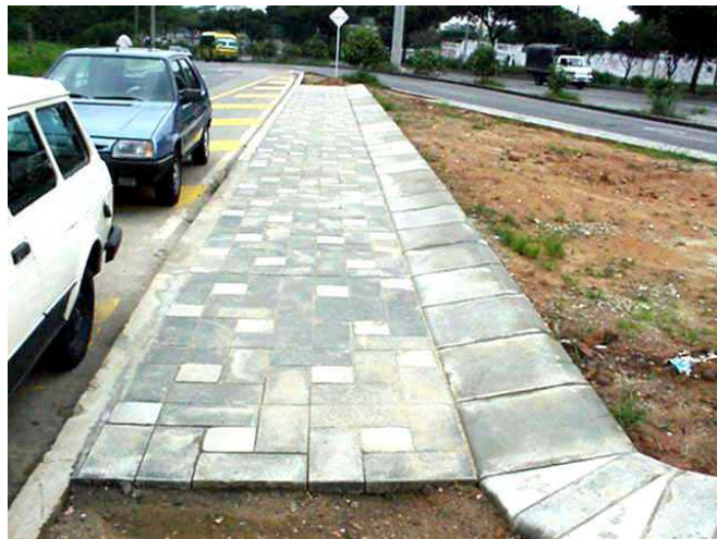
IMAGEN 10: Estado actual del lote No 2.
