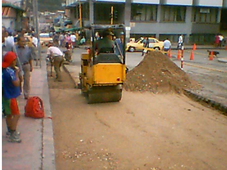
IMAGEN 4: Ejecución de las obras No 2
