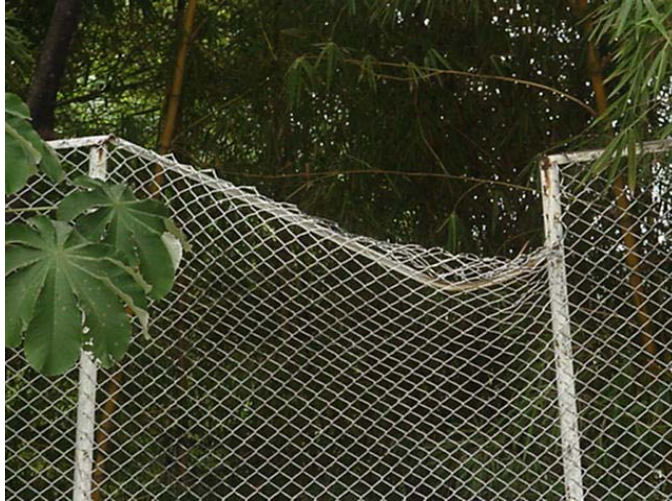
IMAGEN 15. Estado original del polideportivo No. 3
