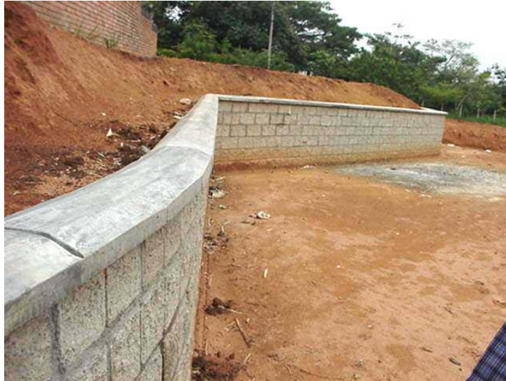
IMAGEN 9: Estado actual del lote No 1
