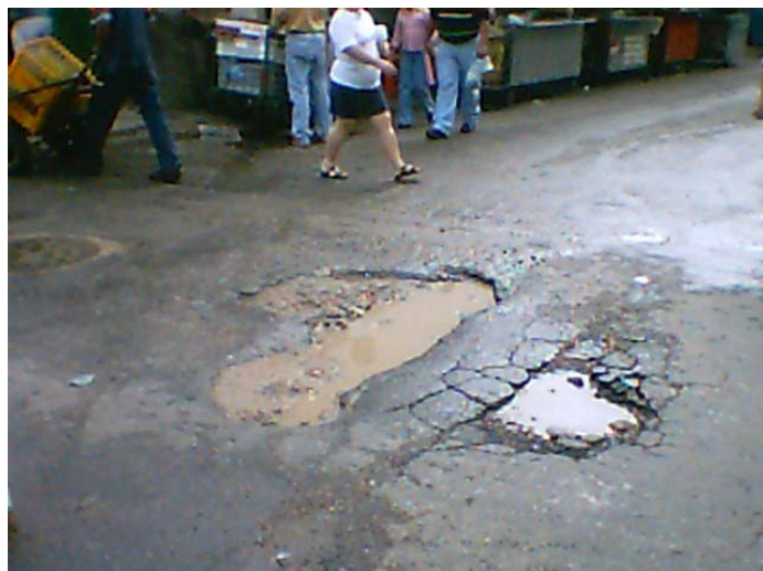
IMAGEN 1: Estado original de las vías No. 1
