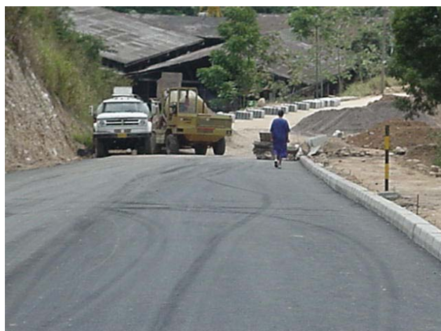
IMAGEN 11. Ejecución de las obras
