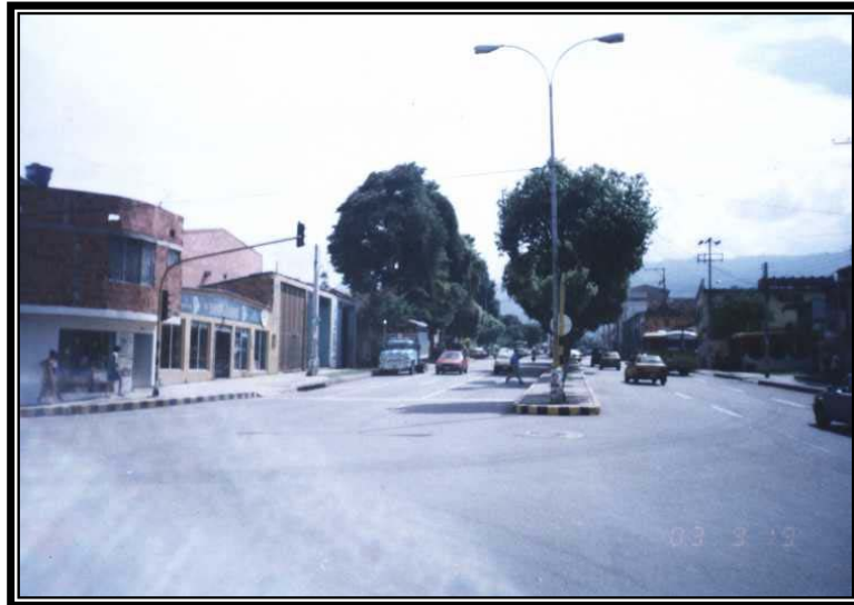
IMAGEN 18. Inicio del proyecto de la prolongación de la carrera 9 con 45
