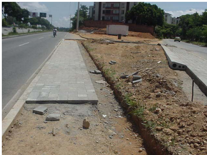
IMAGEN 8: Ejecución de las obras preliminares No 2
