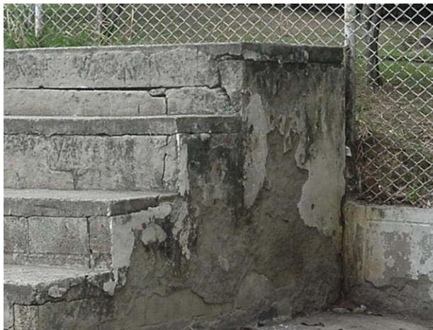
IMAGEN 13. Estado original del polideportivo No. 1
