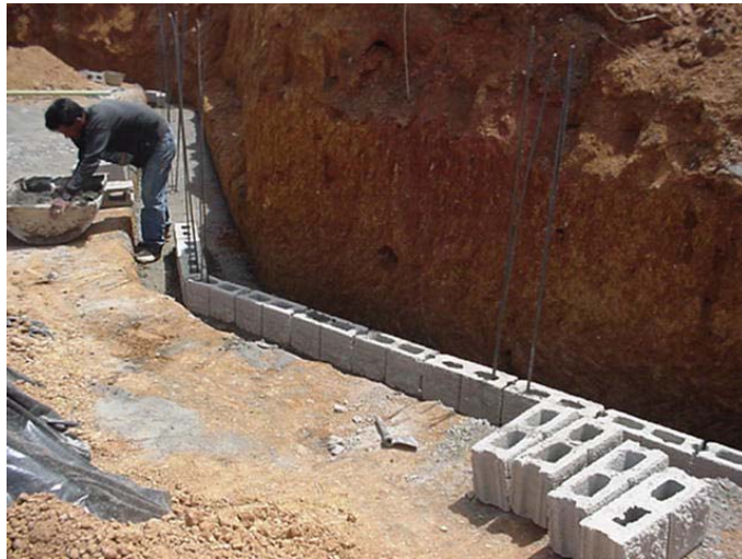
IMAGEN 7: Ejecución de las obras preliminares No 1
