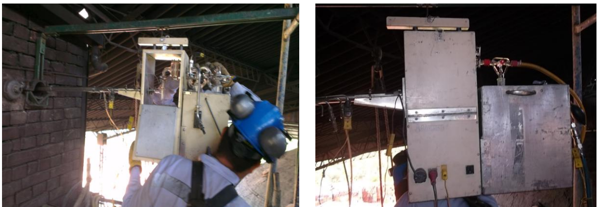
Figura 17. Instalación de la sonda, caja caliente y caja fría en la chimenea
