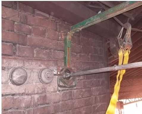
Figura 15. Instalación del soporte del equipo muestreador en la chimenea
