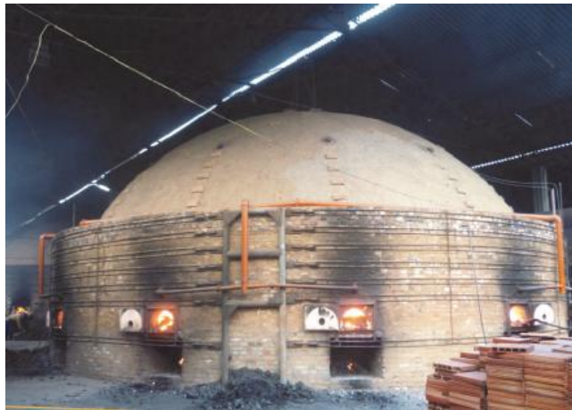
Figura 46. Sistema OVERFIRE-AIR en un horno colmena
