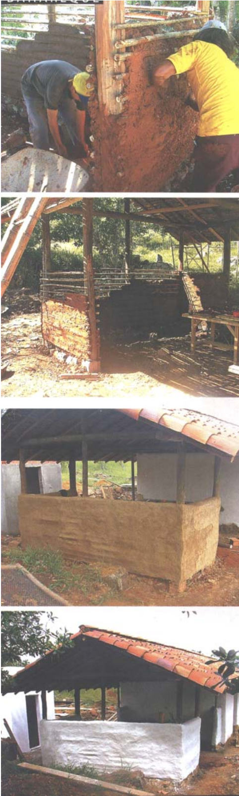
Fotografía 13. Proceso de construcción en la técnica del bahareque
