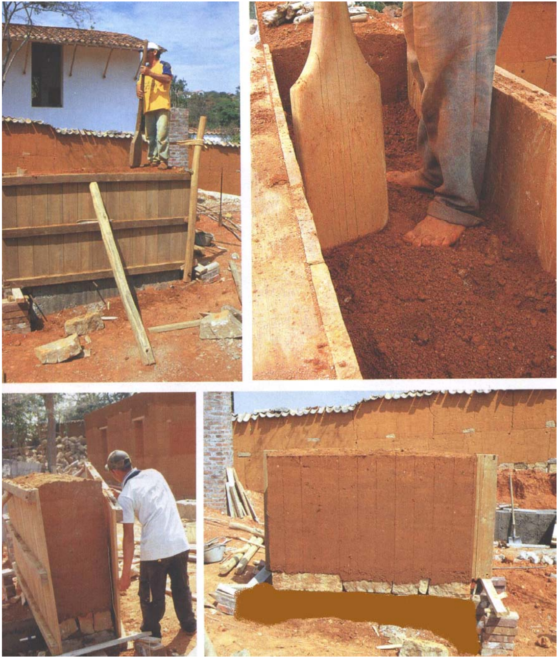
Fotografía 12. Proceso de construcción de tapia pisada
