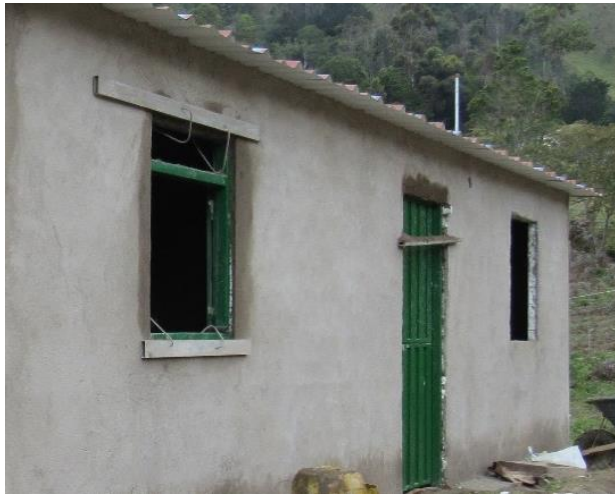
Figura 18. Instalación de carpintería metálica.
