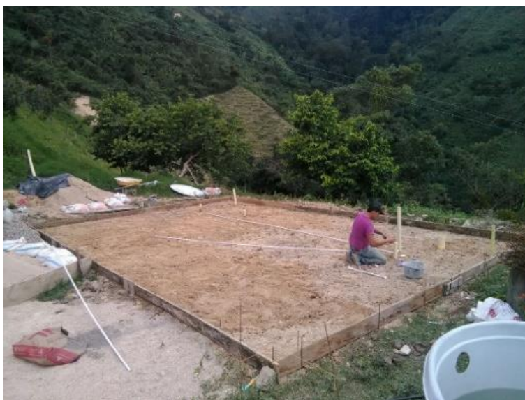
Figura 10. Replanteo, nivelación y armado de formaleta.
