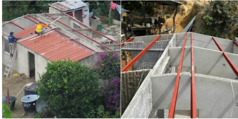
Figura 15. Instalación de la cubierta.
