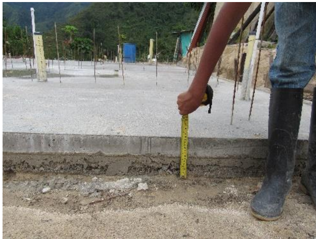
Figura 13. Desencofre de la placa.
