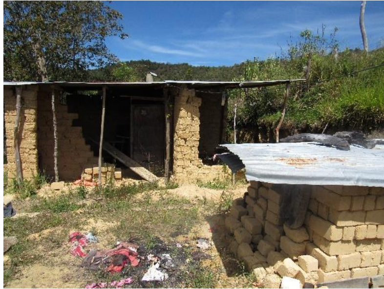
Figura 7. Vivienda afectada en proceso de demolición.
