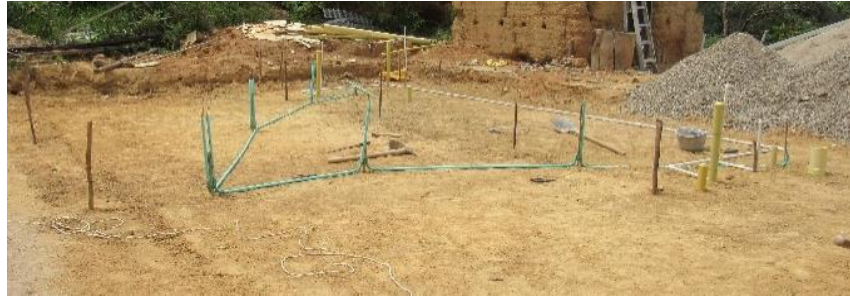
Figura 12. Instalaciones eléctricas, hidráulicas y sanitarias.
