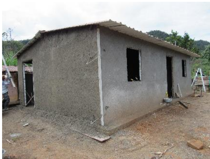
Figura 17. Vivienda tipo 2 frisada.
