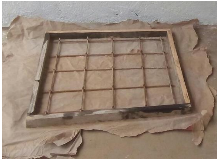
Figura 23. Formaleta de la tapa para los tanques sépticos.
