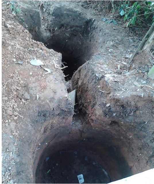
Figura 30. Pozos sépticos extraídos.
