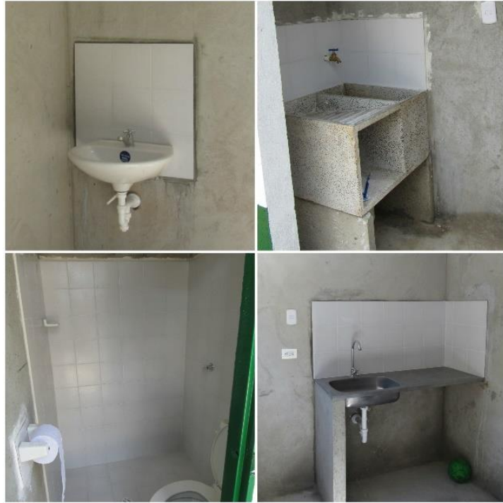
Figura 19. Acabados de la vivienda.
