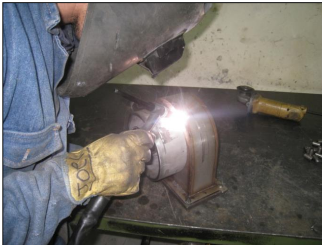
Figura 75. Proceso de soldado de los acoples de la válvula.
