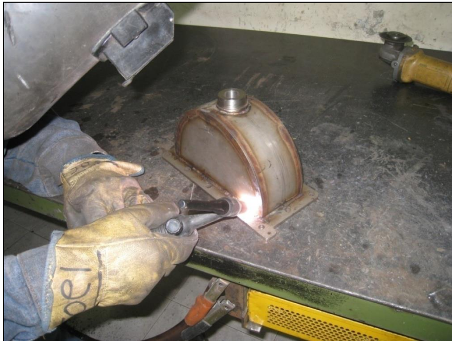
Figura 73. Proceso de soldado de la parte superior del bastidor.
