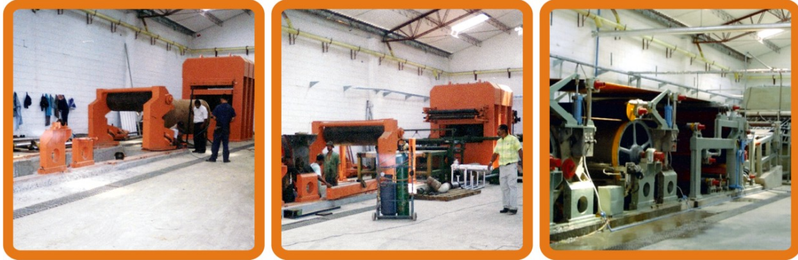
Figura 3. Montaje de maquinaria en la empresa
