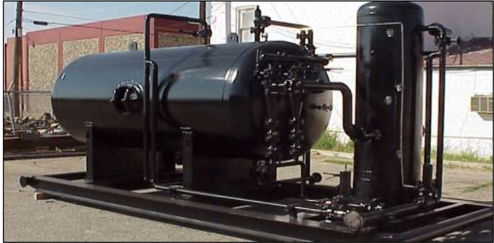
Figura 20: Skid de separación y cabeza de Jet Pump.
