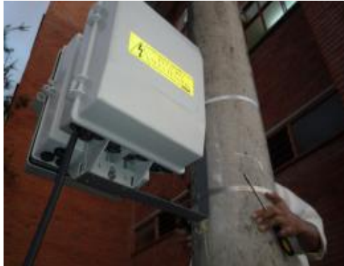
Figura 39. Implementación del prototipo final sistema de comunicación y de calidad de energía
