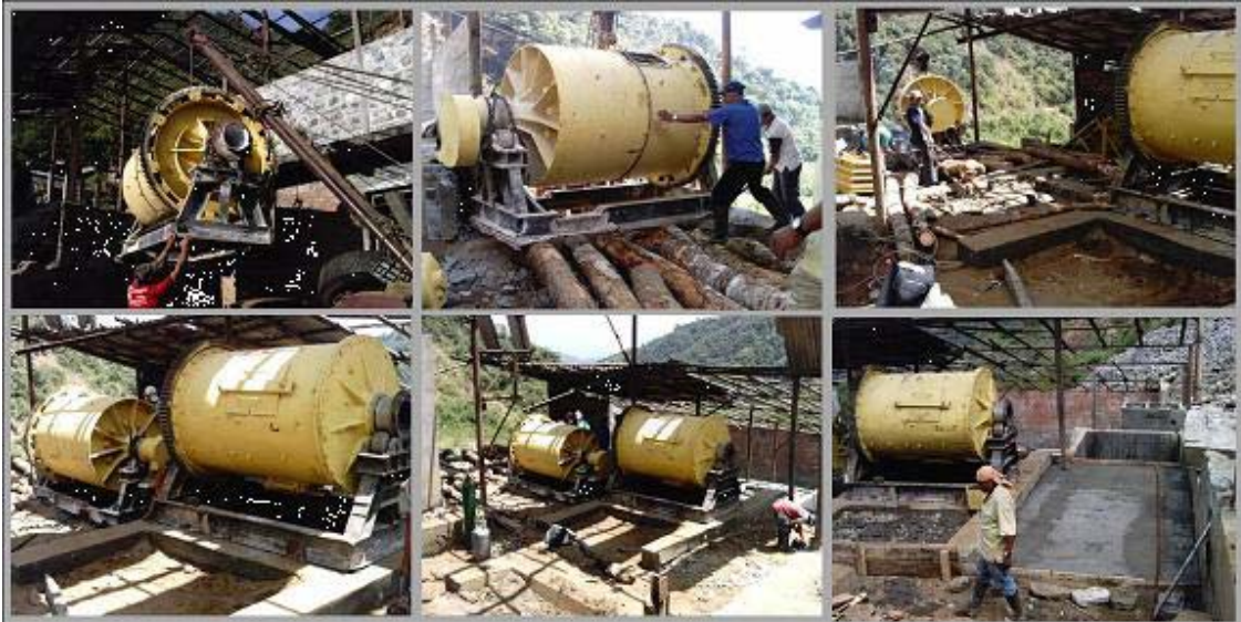
Fig 26. Ubicación de los molinos en las zapatas, Planta de Beneficio, Proyecto EL CERRO.
