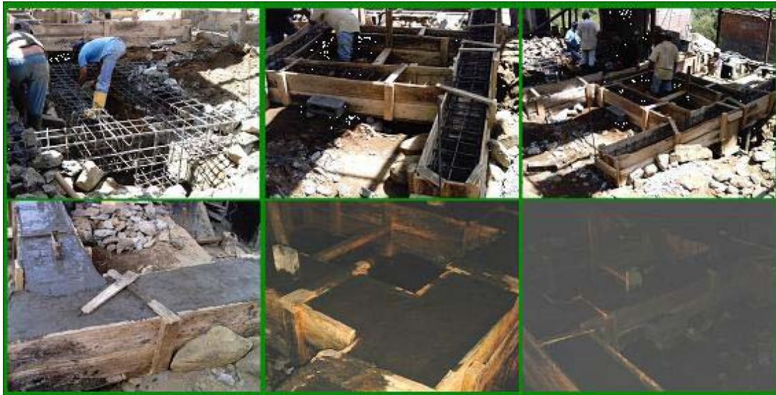
Fig 22. Elaboración de zapatas para los molinos de bolas.
