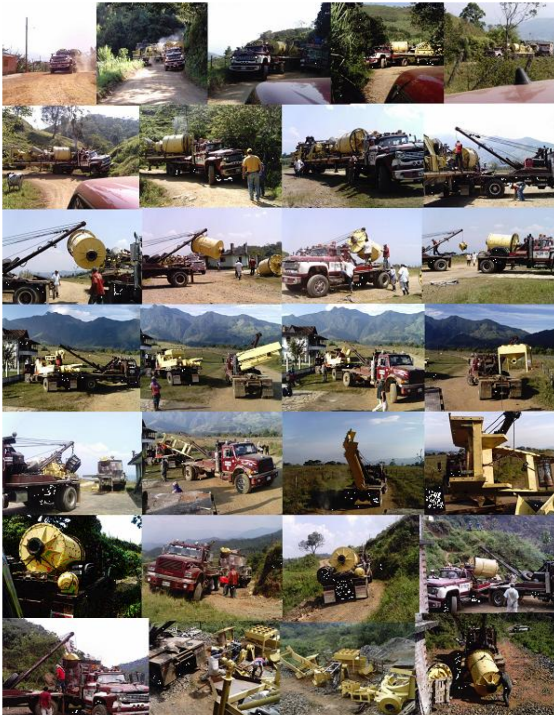
Fig 25. Registro fotográfico del transporte de maquinaria hasta el aeropuerto, descargue y cargue en la cama baja pequeña y colocación en el lugar destinado, Proyecto EL CERRO.
