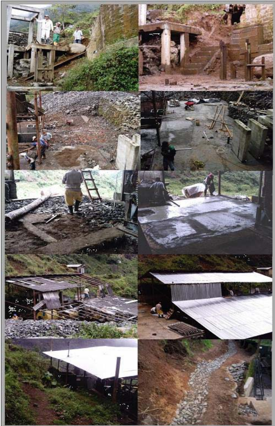
Fig 27. Readecuación, limpieza, elaboración de pisos, escaleras, colocación de tejas etc., de la Planta de beneficio, Proyecto EL CERRO.
