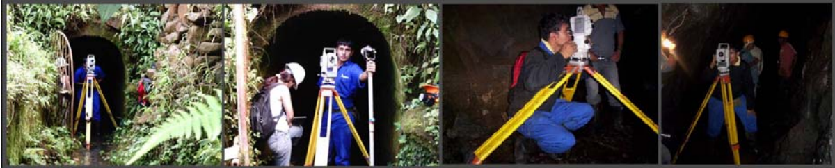
Fig 20. Levantamiento topográfico túnel La Cuadrazón. Proyecto EL CERRO
