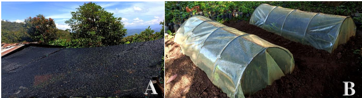
Figura 1. Adecuación y construcción de los dos micro túneles.
