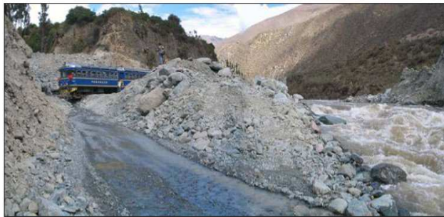
Foto 1. Línea férrea habilitada después del 12 de octubre, mostrando el flujo de detritos en ambas márgenes del río Vilcanota
