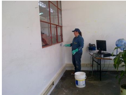
Foto 47. Mantenimiento de paredes. Oficina T8
