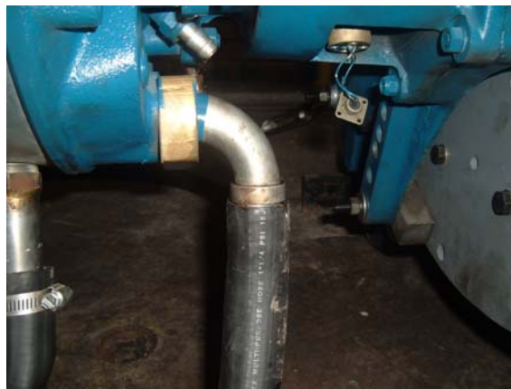
Figura 113. Entrada de Agua.
