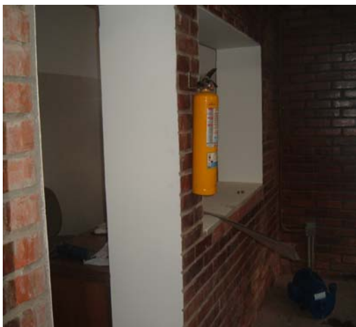
Figura 66. Extintor y Aviso informativo
