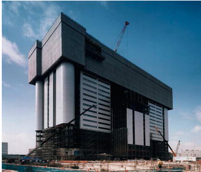
Figura 14. El sistema ABCS construyendo el edificio NEC en Tamagawa.
