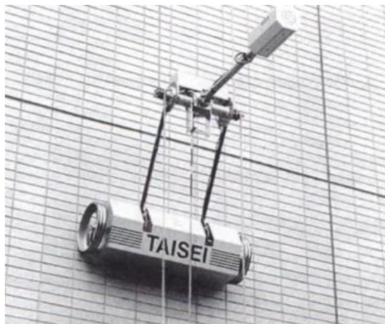
Figura 11. Robot de inspección de baldosas de Taisei.
