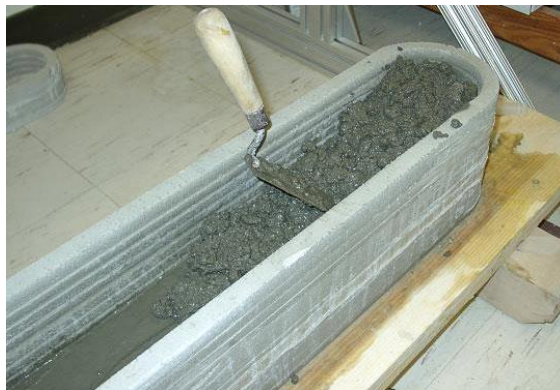
Figura 29. Llenado de concreto capa por capa.
