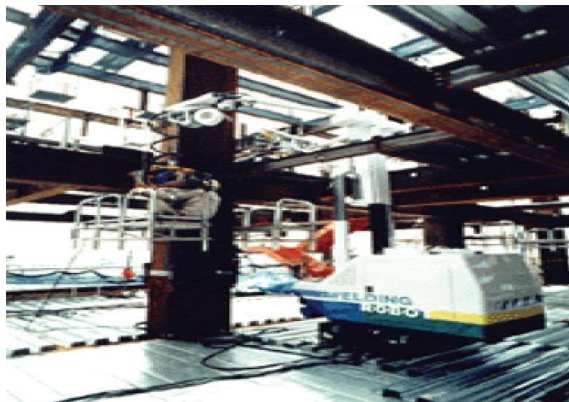
Figura 24. Robot móvil WR de fundición de columnas.
