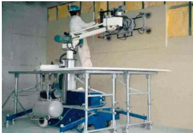
Figura 12. Robot manipulador Tokyu para materiales livianos.
