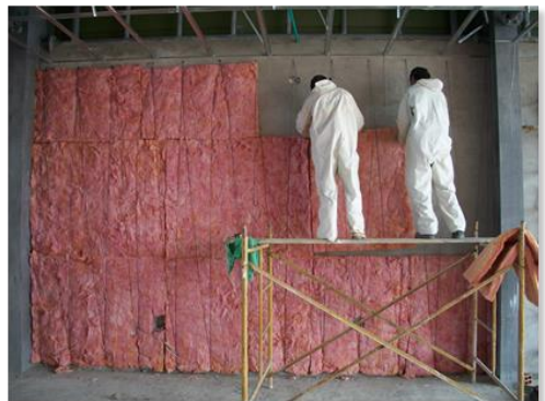
. Parte de la Ejecución del Diseño de Aislamiento Acústico.
