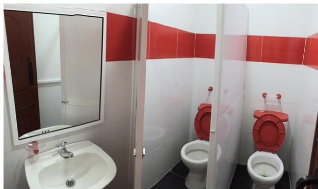
Vista General de la Sección de Mujeres de la Batería de Baños del Primero y Segundo Piso del Edificio Secundario.
