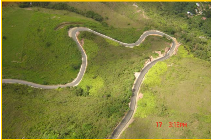
Figura 10. Km 18 Vía Anillo Vial F/Blanca - Ruitoque
