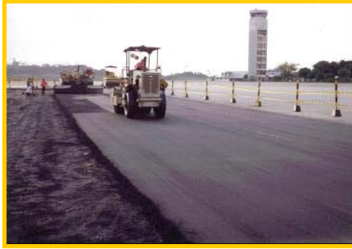
Repavimentación Plataforma Aeropuerto Palonegro
