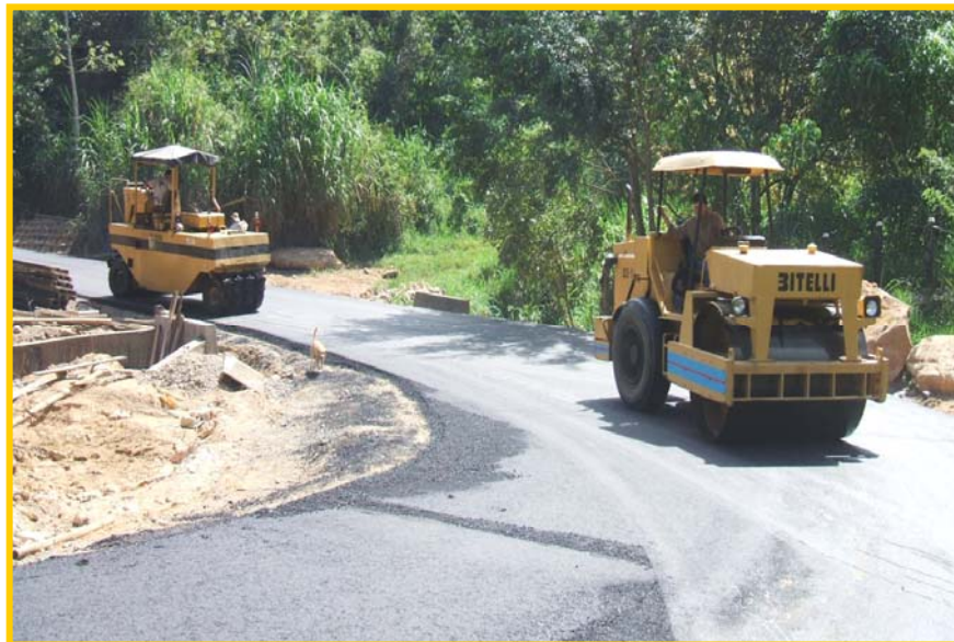
Figura 12. Compactador de llantas (izquierdo) y compactador de rodillo (derecho)
