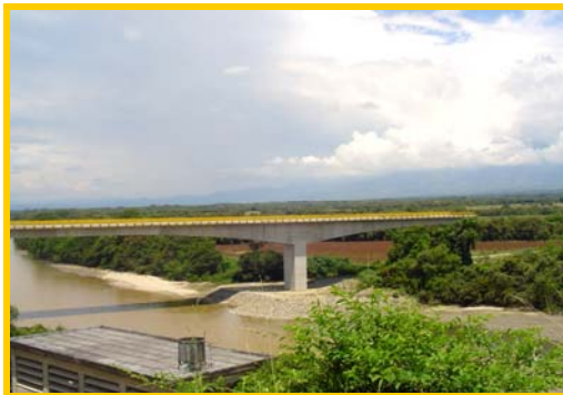
Construcción del Puente "El Juncal" –Neiva
