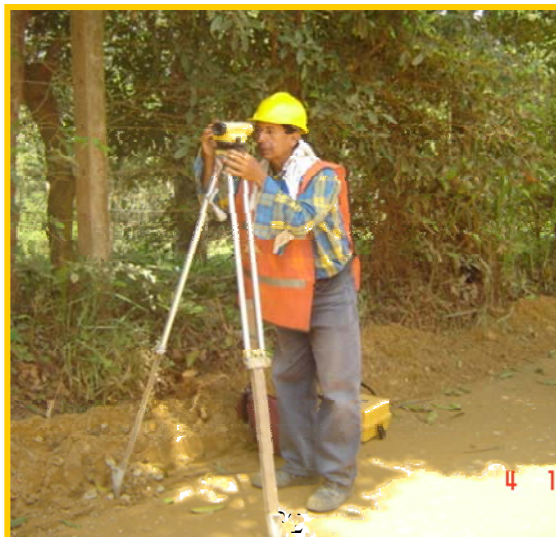
Figura 07. Equipo de Topografía (nivel)
