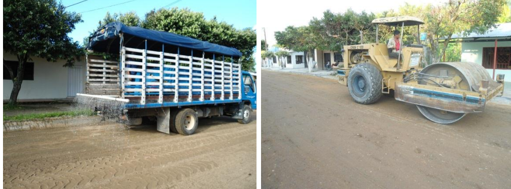
Fotografía 3. Proceso de compactación
