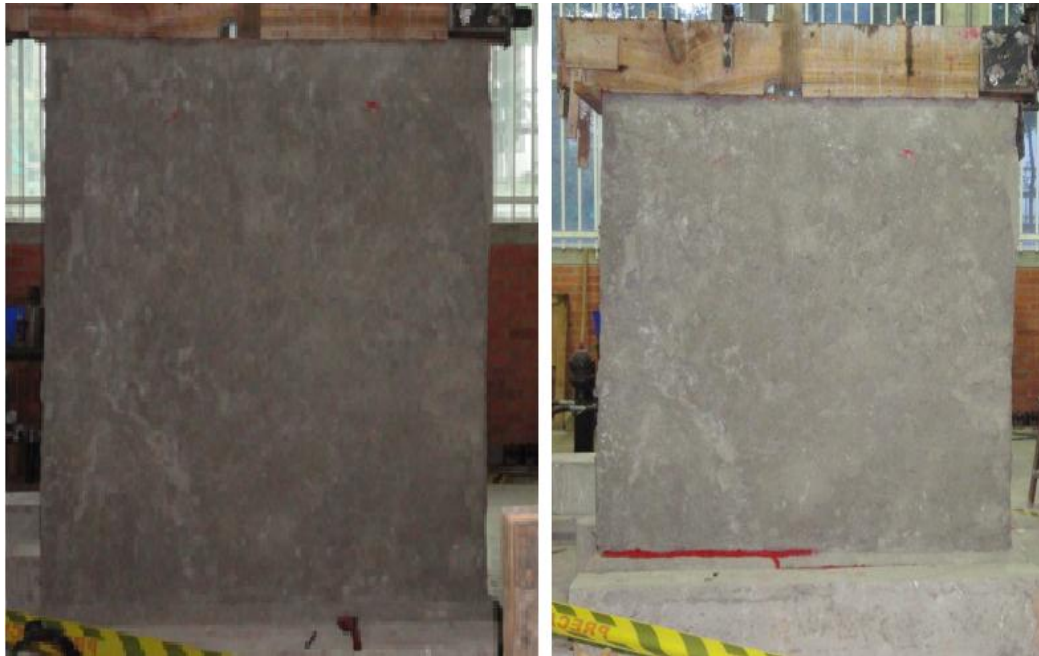
Figura 42. Muro de mampostería reparado y reforzado (MRR3).
