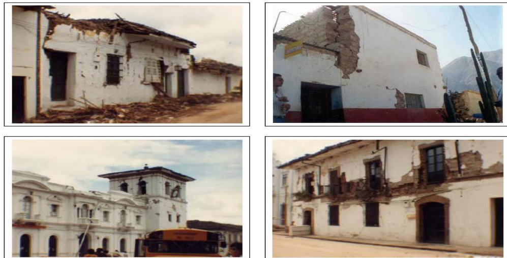
Figura 1. Edificaciones de tierra afectadas por sismos.
