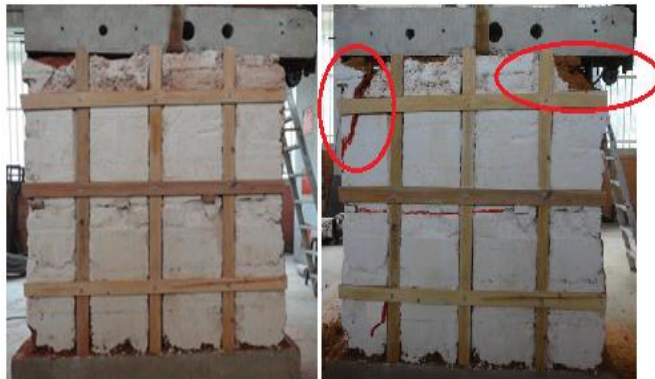
Figura 39. Muro de tapia pisada reparado y reforzado (MRR2).
