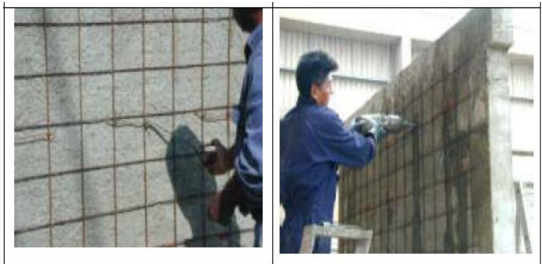
Figura 21. Reforzamiento con malla electrosoldada y mortero.
