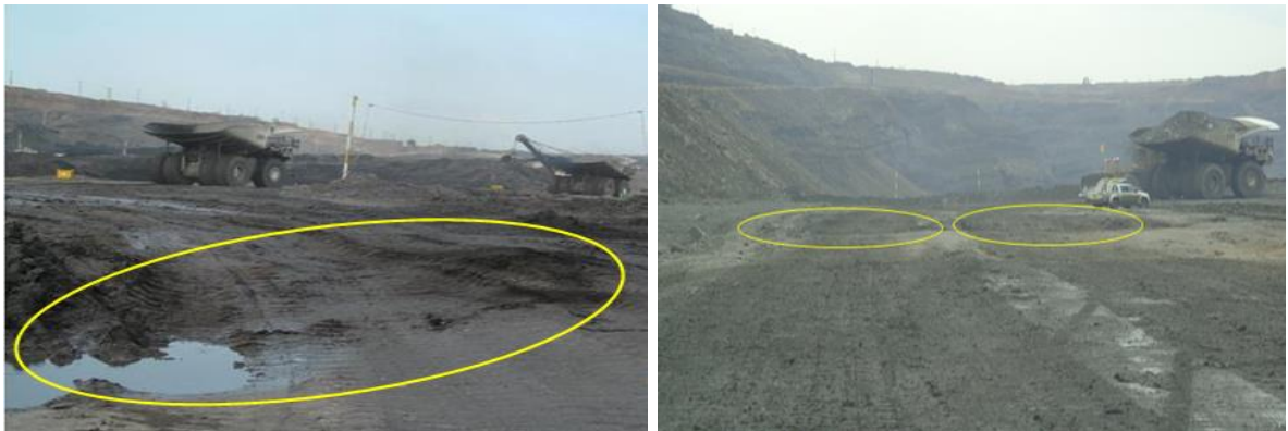
Figura 28. Baches en acceso a área de pala y Baches en acceso a botadero
