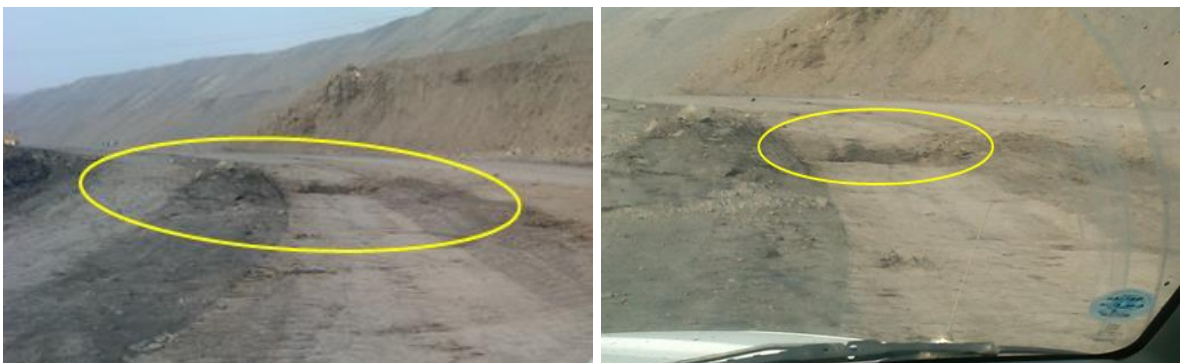
Figura 29. Baches en rampas y corredores
