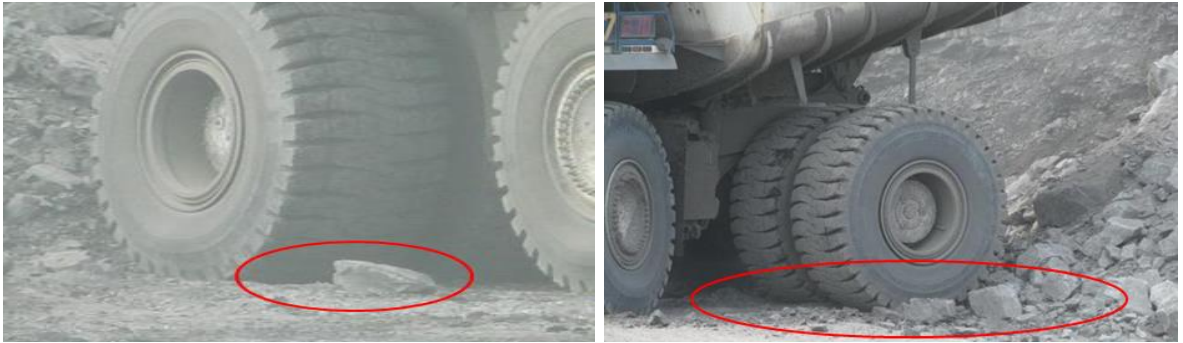
Figura 27. Rocas en el área de cargue y Camión sobre el talud
