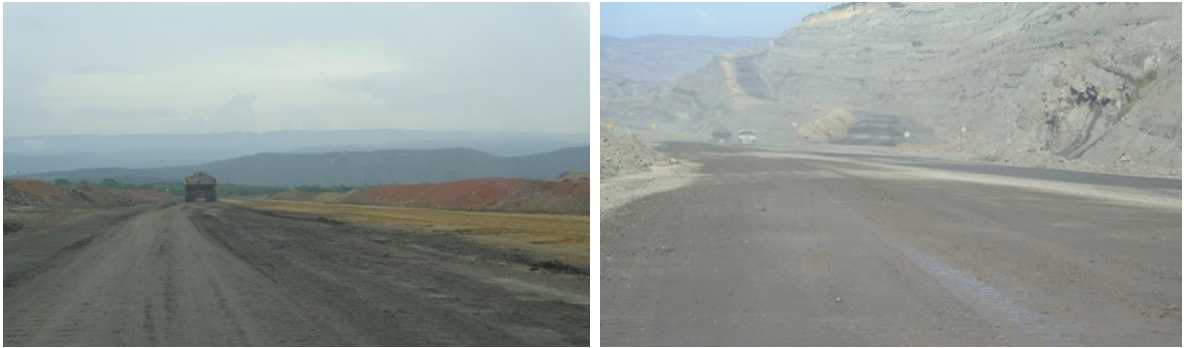
Figura 22. Corredores y rampas
