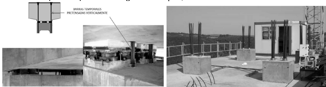
Figura 1.11. Barras temporales Verticales Pretensadas, izquierda. Bloques de anclaje en la parte superior del segmento de pila, derecha
