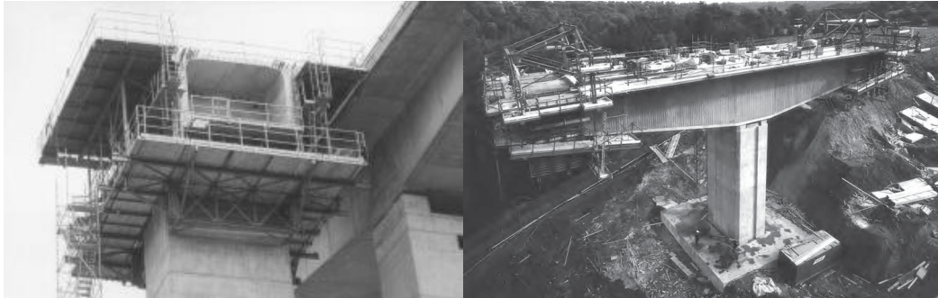
Figura 1.6. Construcción de dovela de pila, izquierda. Puente sobre el río Dee, Newport, UK, derecha
