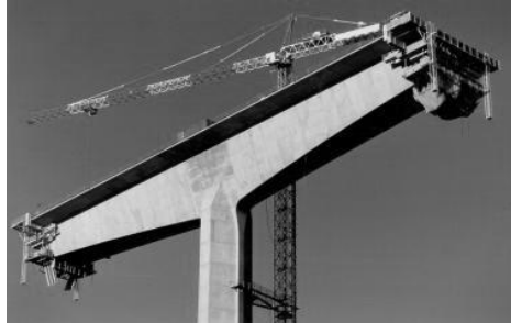
Figura 1.10. Unión rígida o monolítica tablero-pilar
