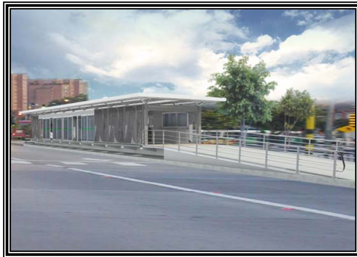
Fotografía 1. Estación tipo parada puerta izquierda.
