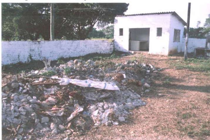
Fotografía 4. Manejo inadecuado de desechos
