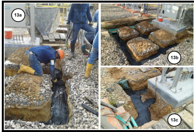
Figura 46. Cemento conductivo para mejoramiento de RPAT en bahía de línea
