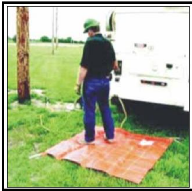
Figura A36. Uso de tapete conductor para proteger al personal.
