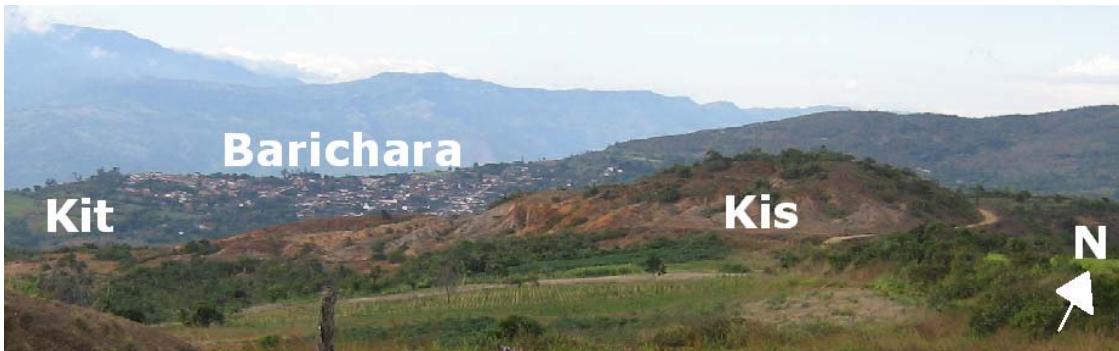
Foto 9. Cerro aislado, perteneciente a la Formación Simití, afectado por erosión severa, en inmediaciones de Barichara, Vda. San José Bajo.
