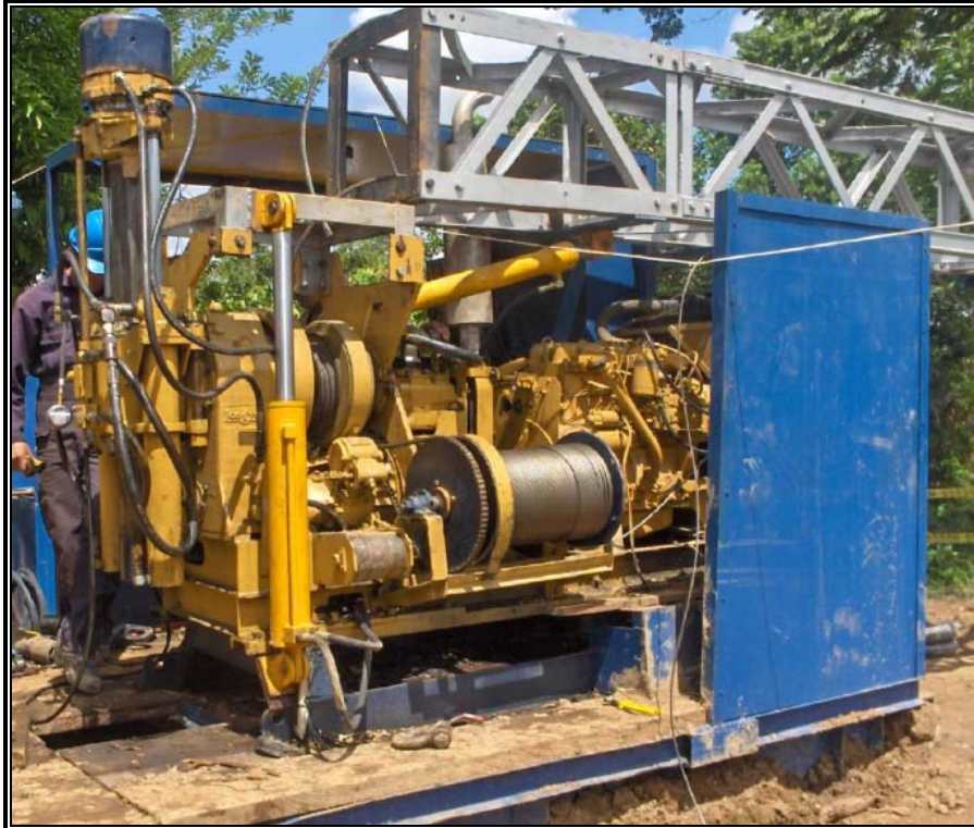
Figura 17. Taladro de perforación tipo Long Year 38.
