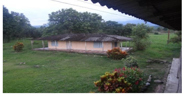
Figura 4. Edificio destinado al hospedaje de profesores y personal ajeno a la comunidad perteneciente a la nómina de la escuela El Chuscal.
