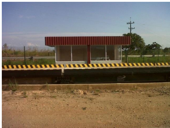
Figura 7. Bascula camionera de 80 Ton
