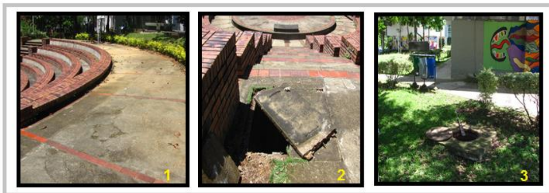
Imagen 21. Nuevos pozos y cajas.
