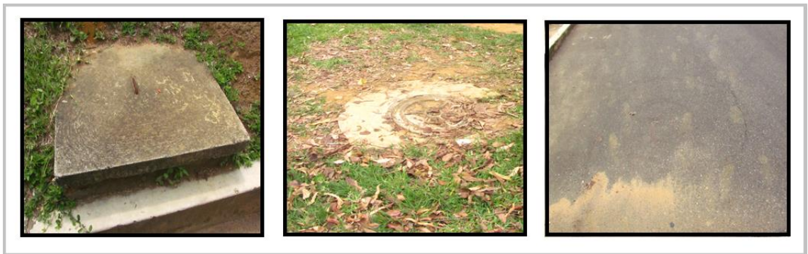
Imagen 45. Pozos y Cajas Ocultos.
