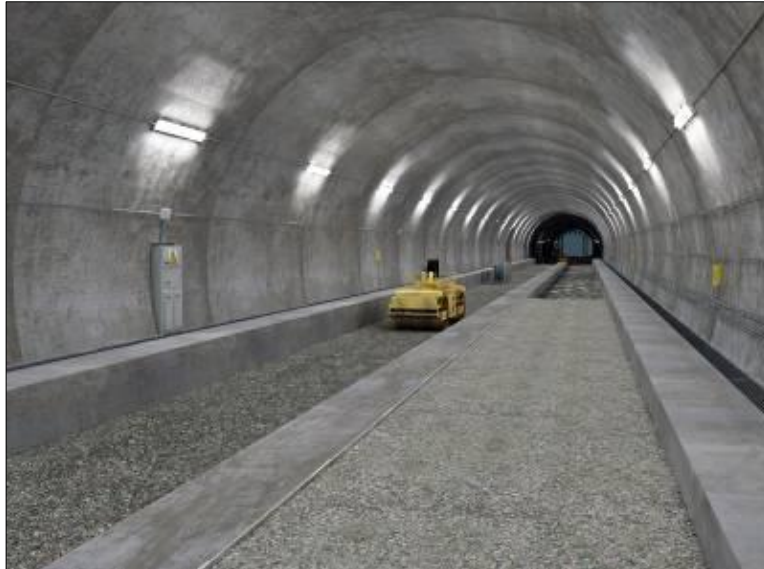
Figura 6. Sostenimiento definitivo de un túnel.
