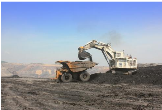
Figura 18. Fotografía del cargue de un camión de 240 toneladas
