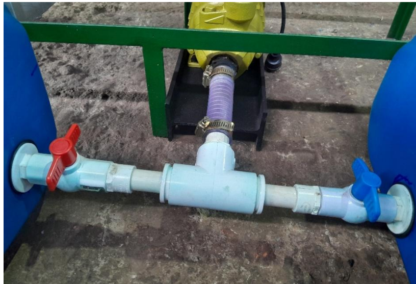
Figura 62. Instalación de PVC en la succión de la bomba.
