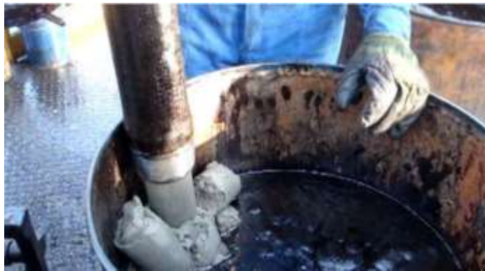
Figura 13.. Limpieza de arena de la recamara bomba desarenadora
