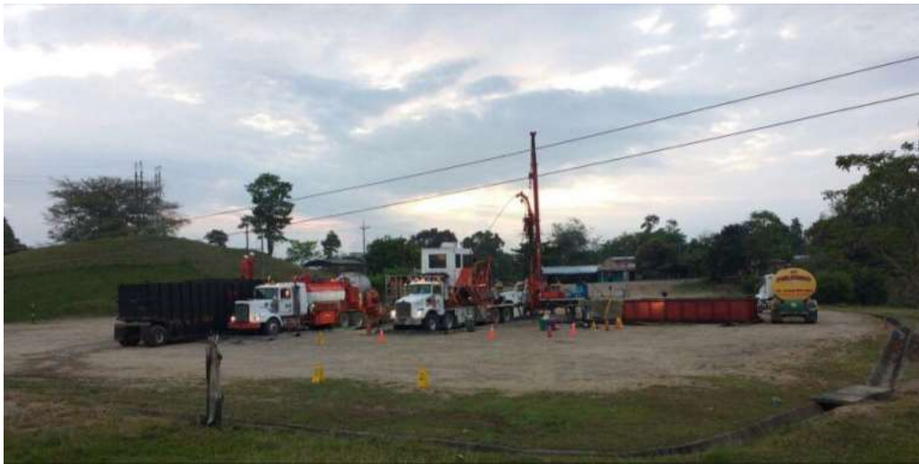
Figura 21. Layout limpieza de arena con unidad coiled tubing pozo #134
