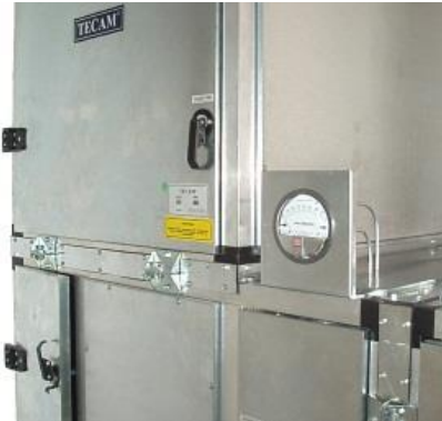
Figura 27. Manómetro de presión diferencial
