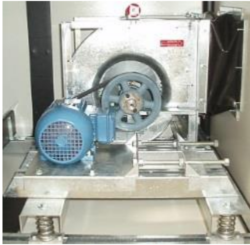
Figura 23. Seccion de transmision ventilador
