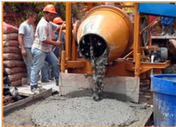
Figura 2. Mezclado de concreto en obra.
