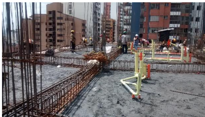
Figura 13. Evidencias construcción obra – Armado de vigas y columnas
