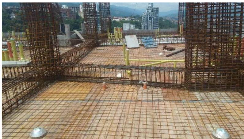
Figura 13. Evidencias construcción obra – Armado de vigas y columnas
