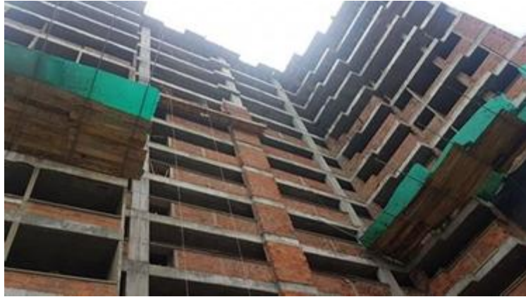
Figura 3. Detalle muros de mampostería – primer alzado
