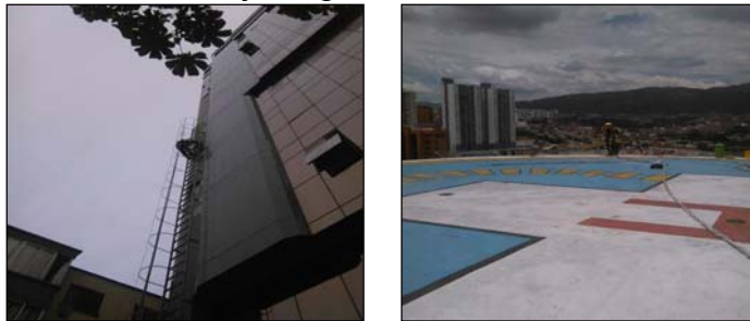
Piso 3, parte posterior del edificio (fachada)
