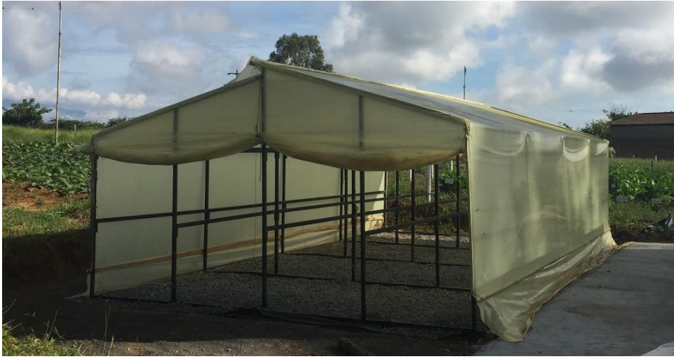
Figura 17. Caney cubierto de plástico de prueba o estructura VSC.
