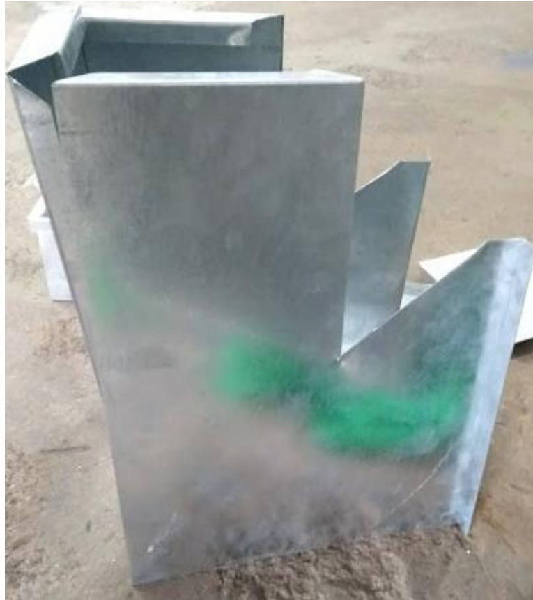
Figura 58. Ducto en construcción
